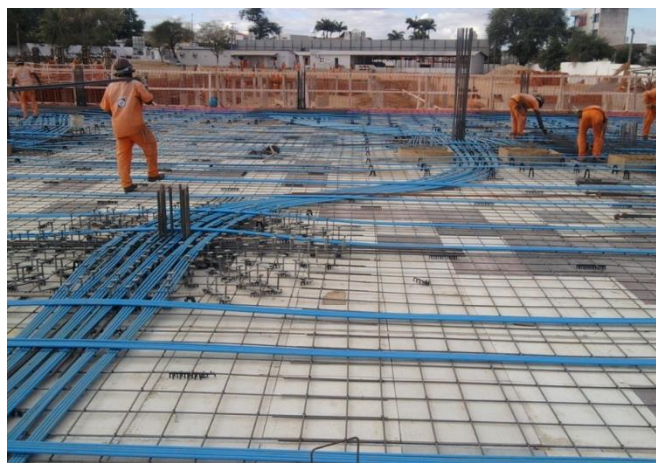
Figura 2.27: Montagem de laje lisa com cordoalha engraxada de aço CP-190 RB
