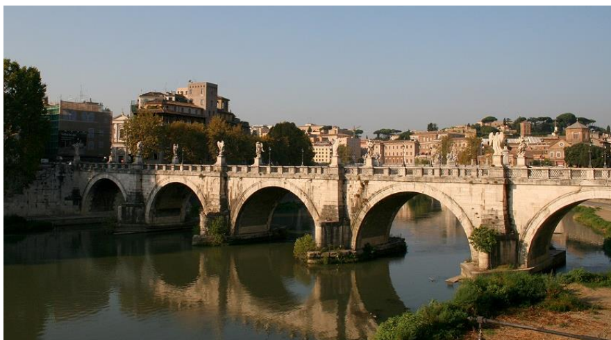
Figura 1.1: Ponte Sant'Angelo em forma de arco com utilização de blocos de pedra
