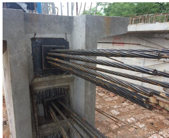
Figura 2.24: Equipamentos de protensão em elemento pré-moldado de concreto
