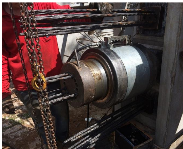
Figura 2.24: Equipamentos de protensão em elemento pré-moldado de concreto
