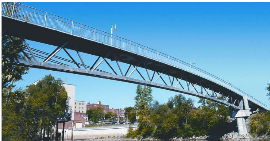
Figura 2.16: Passarela Sherbrooke com treliça espacial de CUAD
