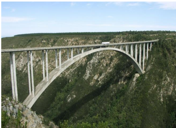
(a) ponte em arco Bloukrans na África do Sul
