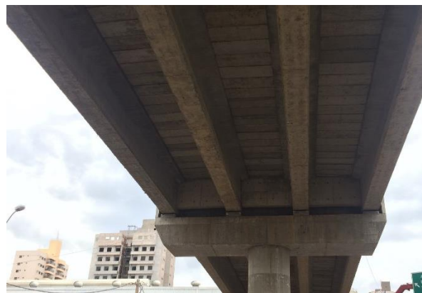
(d) vista inferior da superestrutura composta por 4 longarinas e 2 transversinas de extremidade
