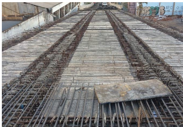
(c) vista superior do tabuleiro do viaduto composto por vigas pré-moldadas e pré-lajes
