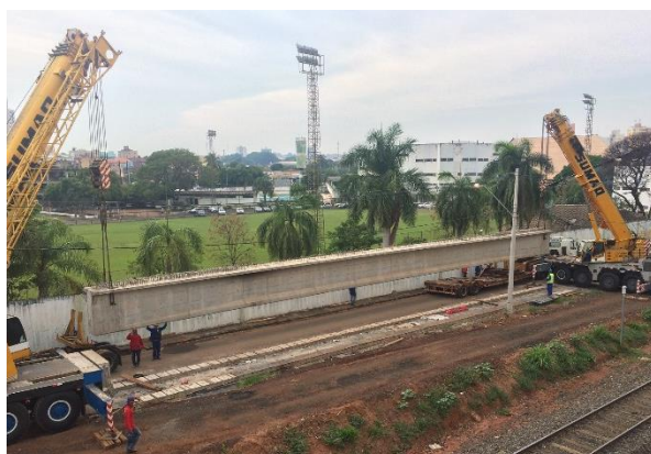
(c) vista superior do tabuleiro do viaduto composto por vigas pré-moldadas e pré-lajes
