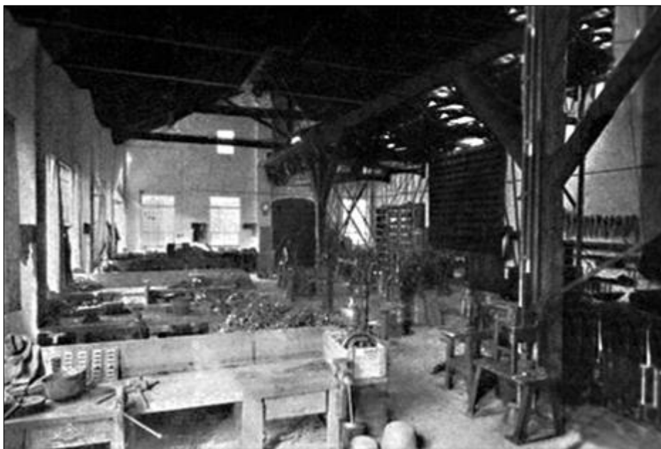
Figura 15 – Imagem do interior da fábrica de Alberto Bins na década de 1910.
