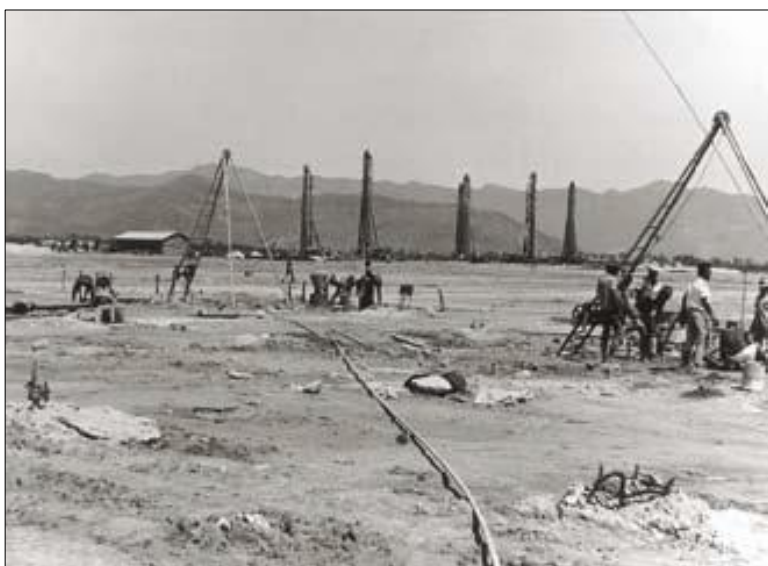
Figura 6 – Instalação da Siderúrgica Guaíba na década de 1970. Fonte: Chama Empreendedora, 2001.
