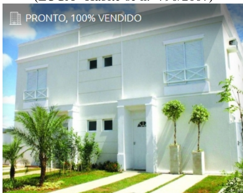
Figura 48 - Conjunto Residencial Green Village III (EUGA - Habite-se n.º 790/2007)
