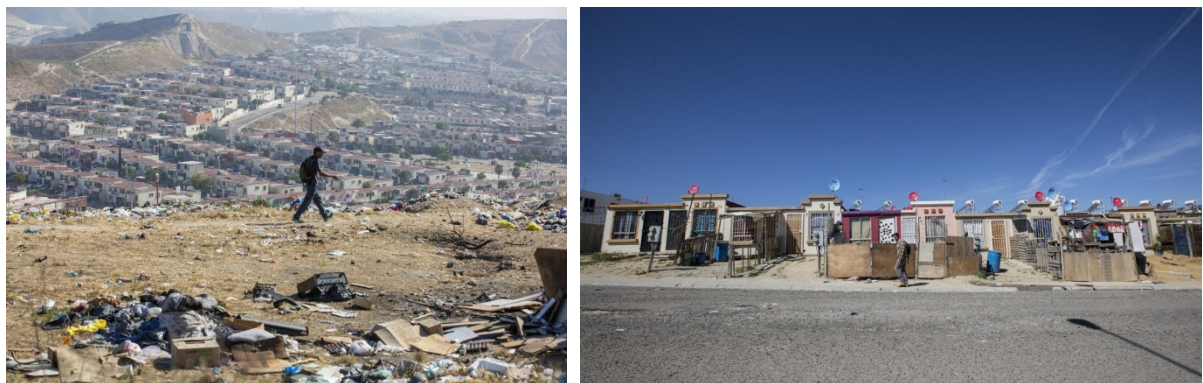
Figuras 11e 12 – Empreendimentos habitacionais de preços acessíveis e de mini casas em Villa del Alamo, localizados em Tijuana no México.
