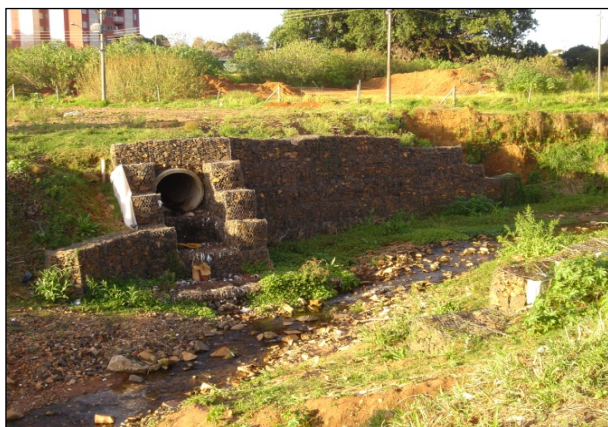
Figura 20 - Obras de contenção de erosão no leito do córrego
