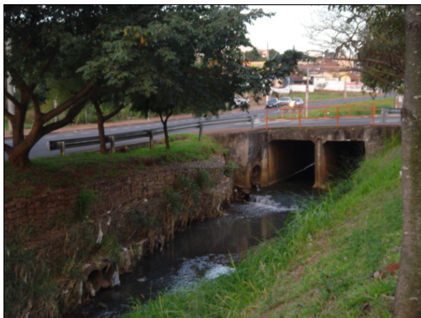
Figura 44 - Obras com grades de pedra para conter o deslizamento de terra no ponto
