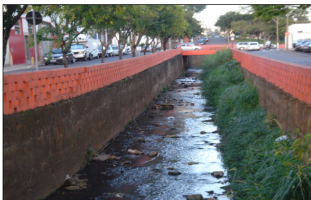
Figura 42 - Lixo e entulho no córrego do Gregório, e a vegetação de APP se resume às poucas árvores implantadas na margem esquerda (observando da foz para a nascente)
