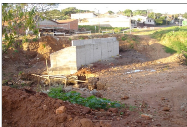
Figura 21- Construção de uma ponte próximo à rua Miguel Giometti
