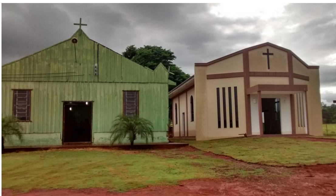
Figura 20 – Vista frontal das igrejas
