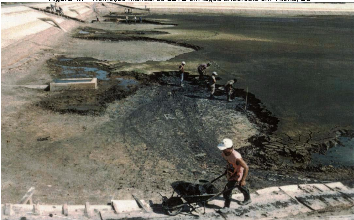
Figura 4.7 - Remoção manual de LETE em lagoa anaeróbia em Vitória, ES
