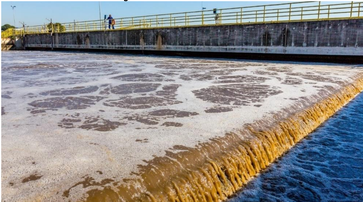
Figura 6.2 - Reator aeróbio da ETE 1
