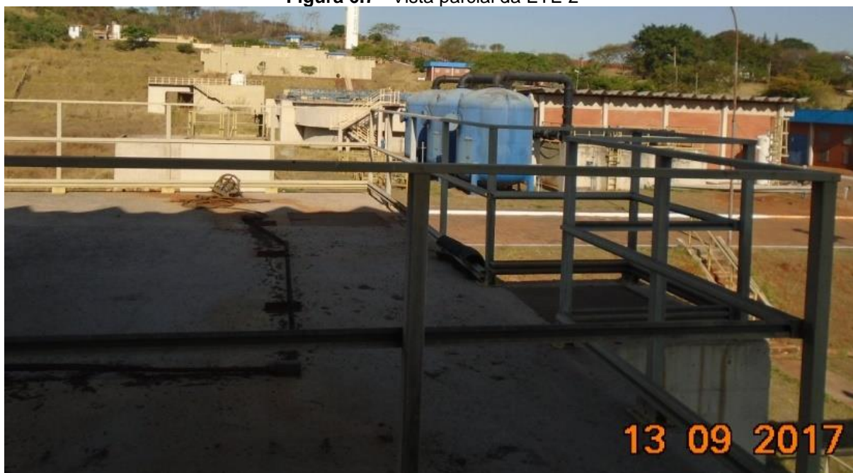
Figura 6.7 - Vista parcial da ETE 2
