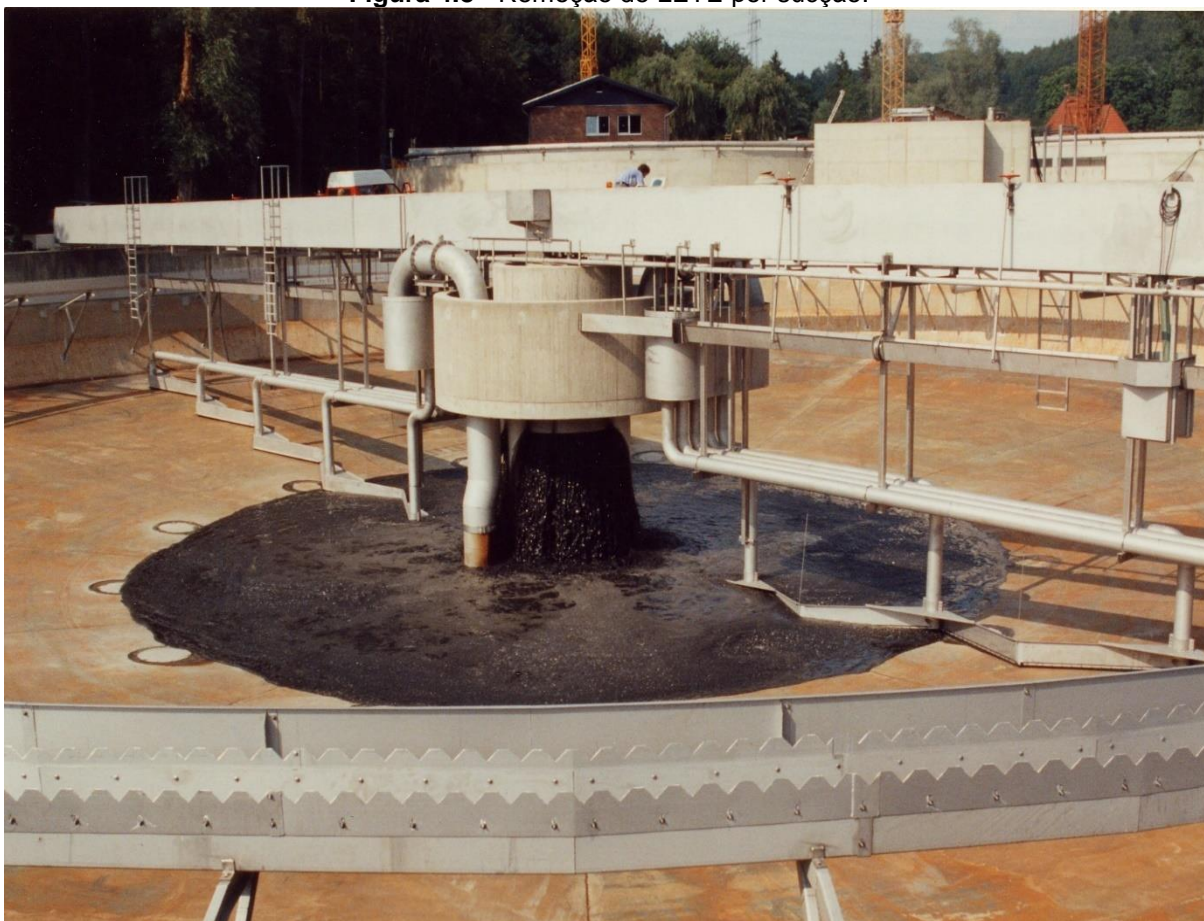
Figura 4.8 - Remoção de LETE por sucção.
