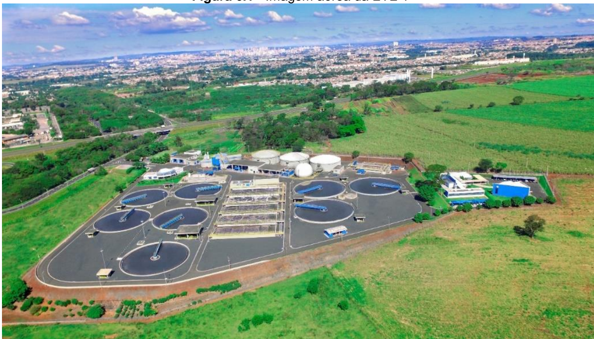
Figura 6.1 - Imagem aérea da ETE 1
