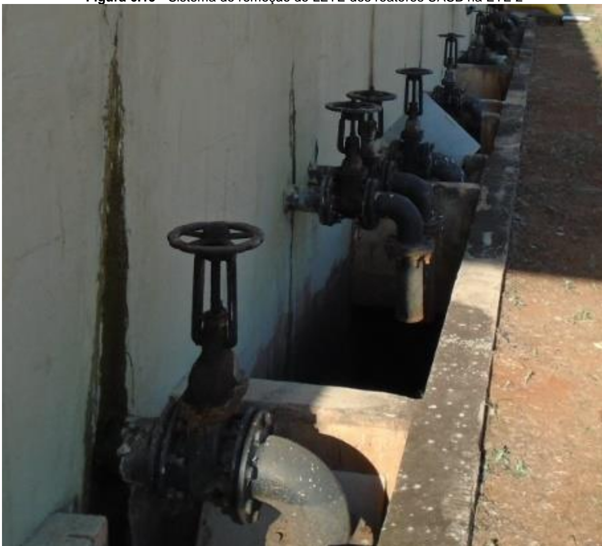
Figura 6.19 - Sistema de remoção do LETE dos reatores UASB na ETE 2
