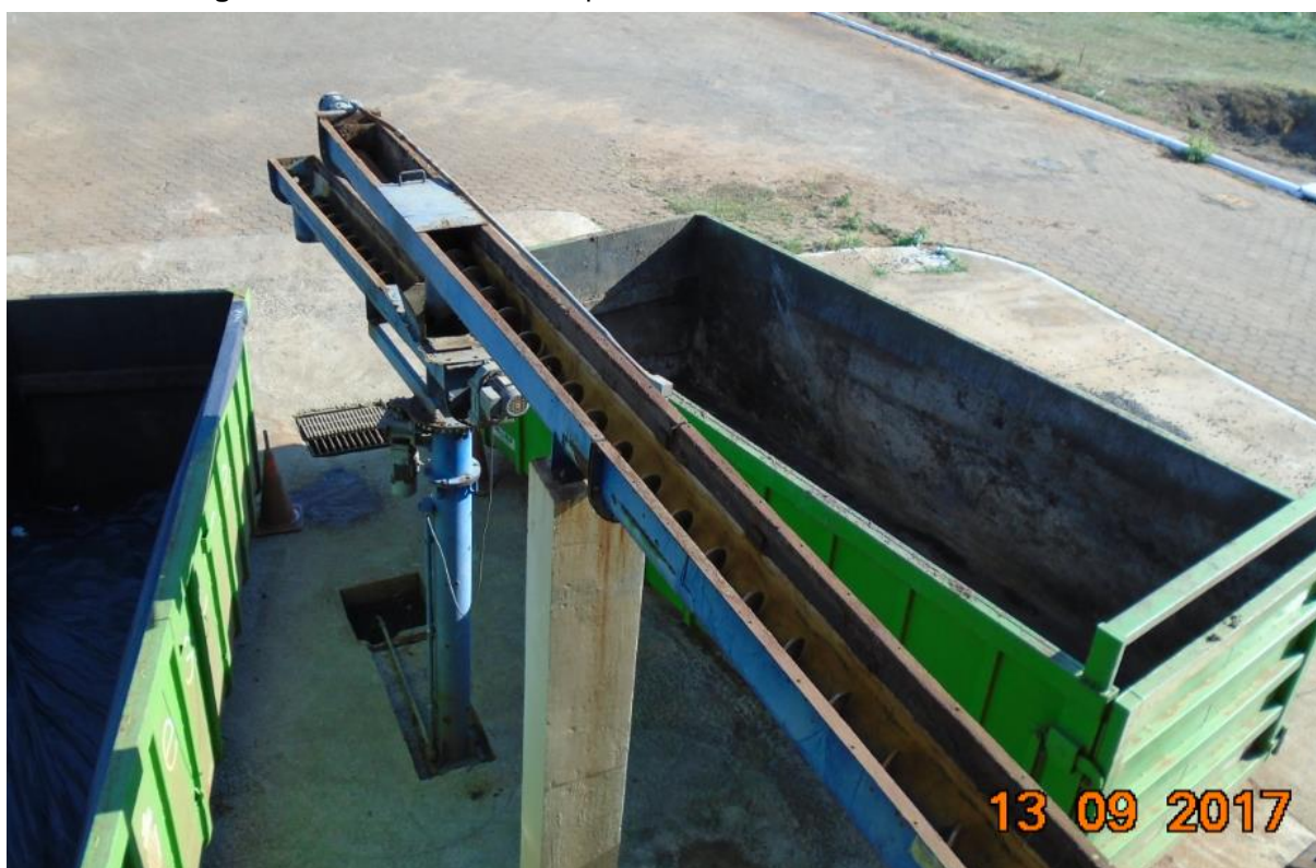
Figura 6.20 - Sistema de transporte e armazenamento do LETE na ETE 2
