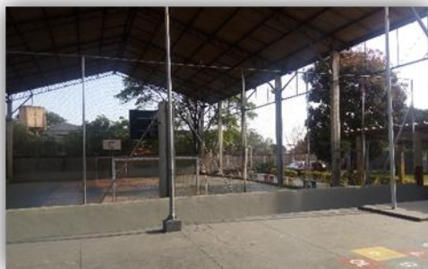
Figura 5- Quadra poliesportiva coberta
