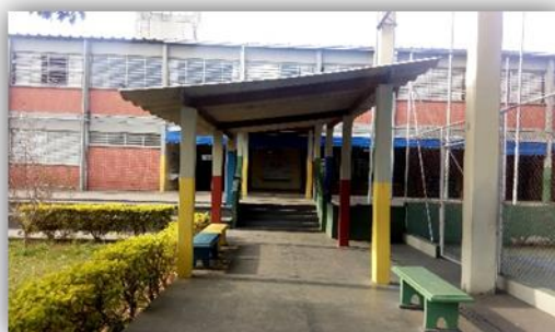
Figura 4- Cobertura entre os pátios, superior e inferior
