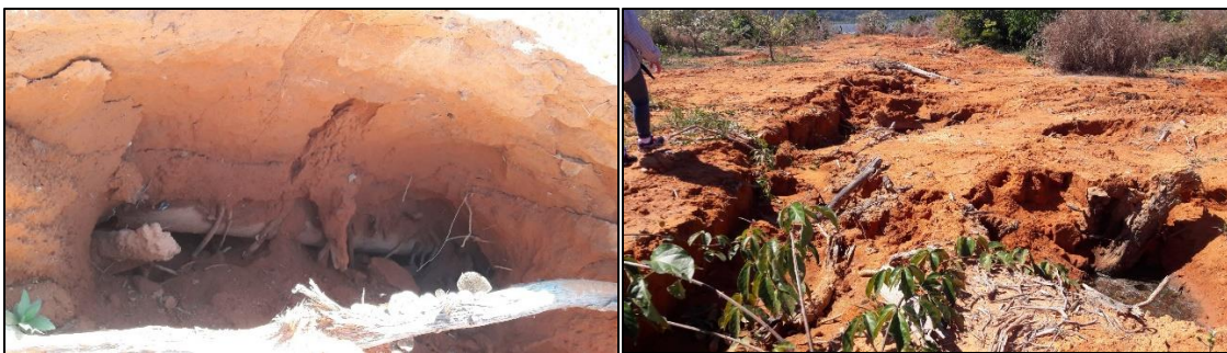
Figura 25. Vegetação soterrada as margens do rio Teles Pires para construção da UHE Colíder Foto: Leila Nalis Paiva da Silva Andrade (2017)
