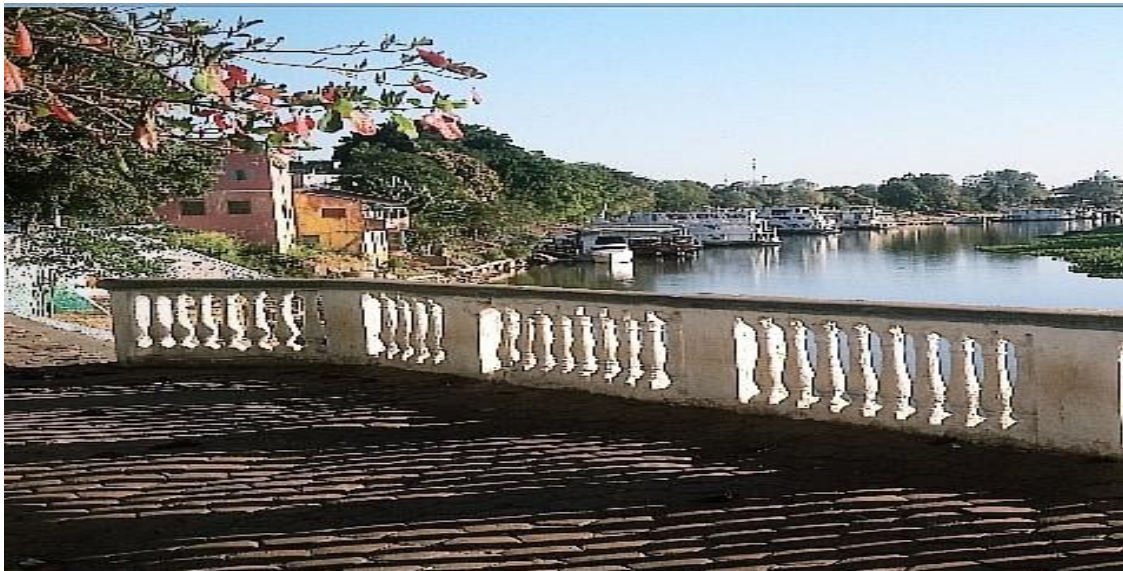
Figura 5 – Vista do Cais da Praça Barão do Rio Branco, Cáceres – MT
