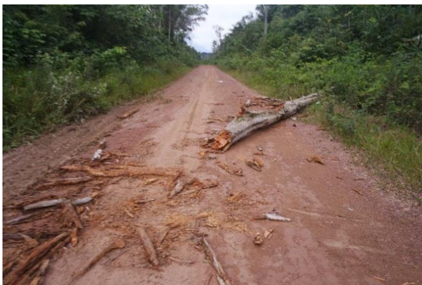
Figura 24 – Árvores caídas na estrada após fortes chuvas
