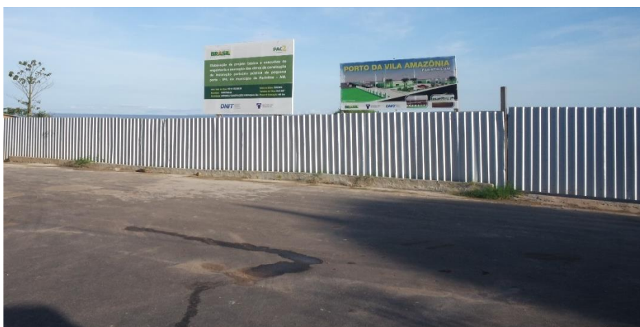
Figura 14 – Construção do Porto da Vila Amazônia
