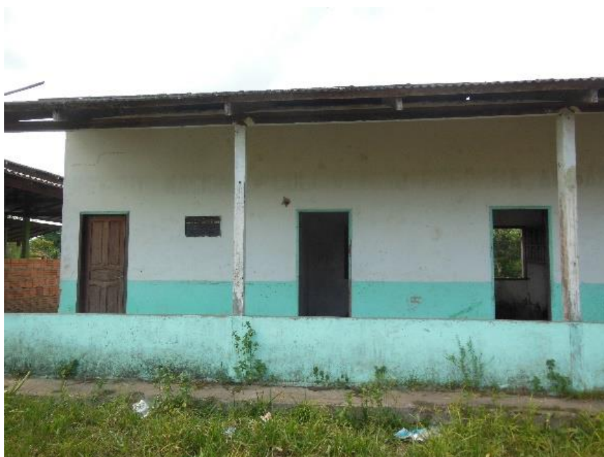
Figura 28 – Prédio abandonado do INCRA
