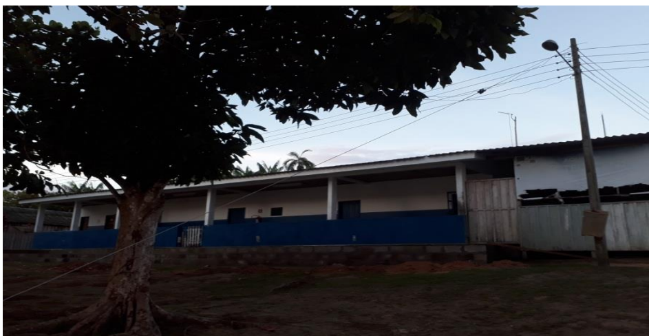
Fachada da Escola Municipal Bom Jesus.
