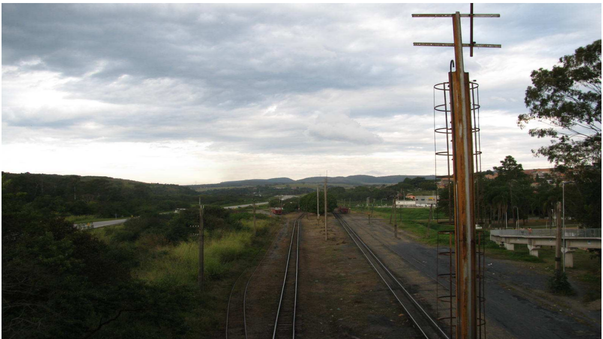
Figura 21: Vista do Pontilhão para a estação ferroviária (Autor: Poliana Bassi Silva, 2009).
