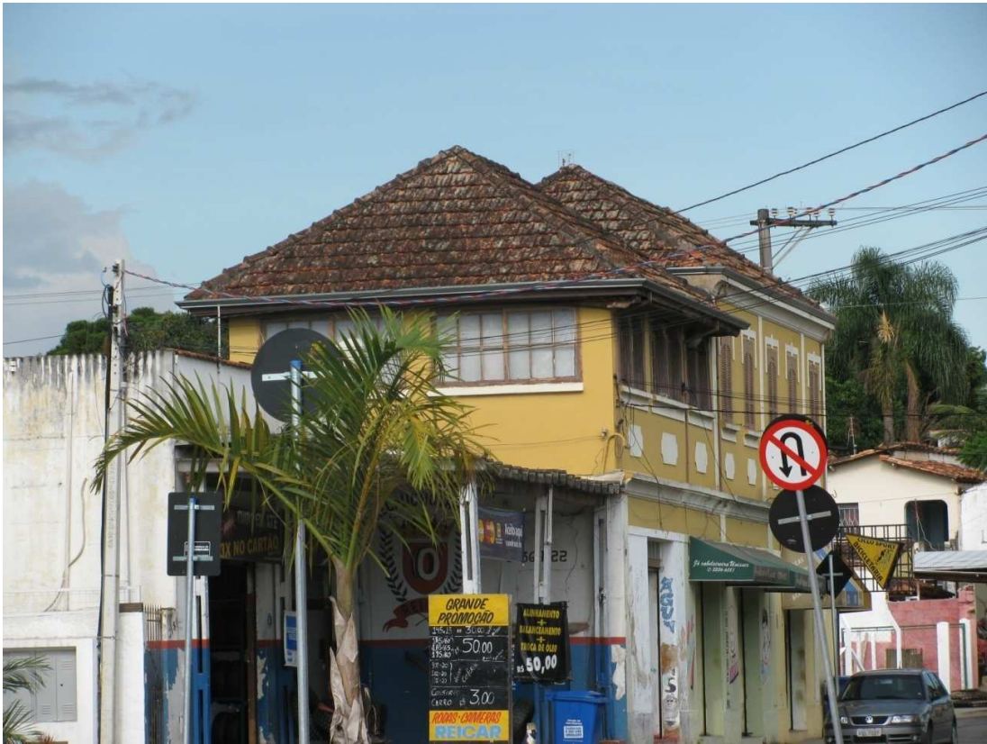
Figura 18: Fachada de casa para levantamento arquitetônico (Autor: Poliana Bassi Silva, 2009).
