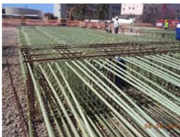
Detalhe da montagem da armadura em fibra de vidro Obra Metrô Fortaleza – Fornecimento Stratus
