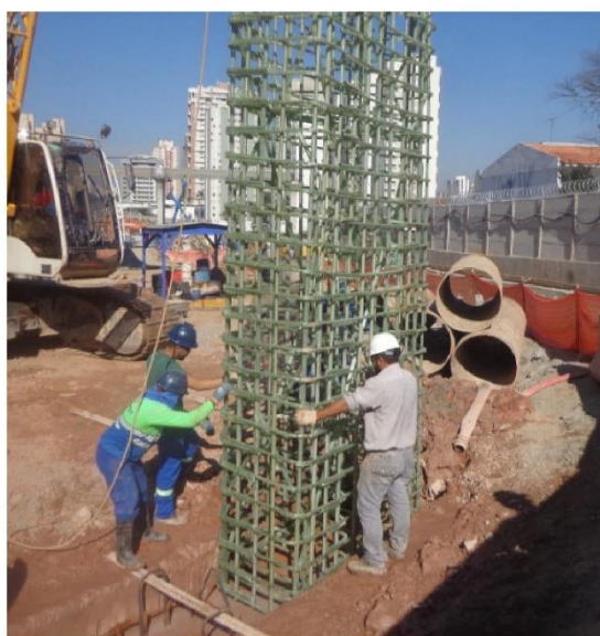
Detalhe da armadura sendo posicionada verticalmente no poço de ataque Obra Metrô São Paulo – Estação Campo Belo - Fornecimento Stratus
