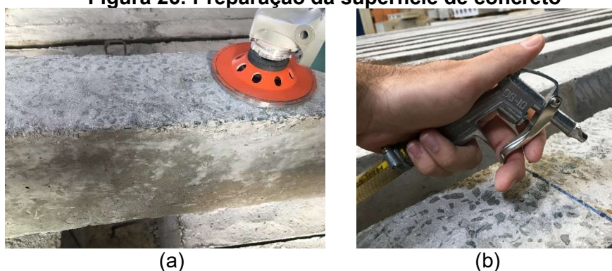
Figura 26: Preparação da superfície de concreto
