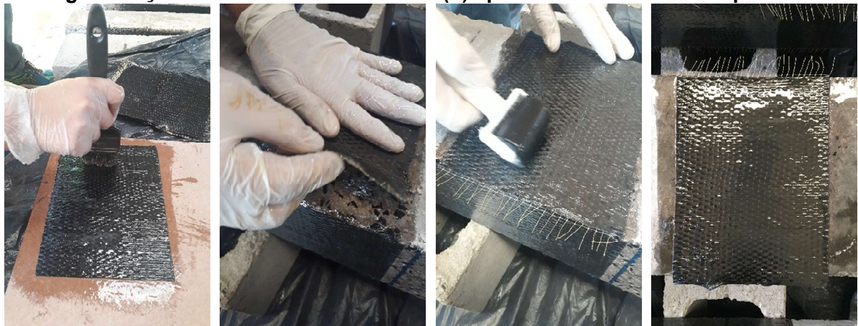
Figura 48: Processo de aplicação do CFRP para os ensaios de aderência: (a) impregnação da manta de fibra de carbono; (b) posicionamento do CFRP; (c) regularização com o rolo de borracha e (d) aparência final do CFRP aplicado
