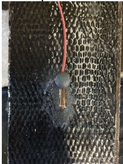
Figura 44: Extensômetro aplicado na manta de fibra de carbono
