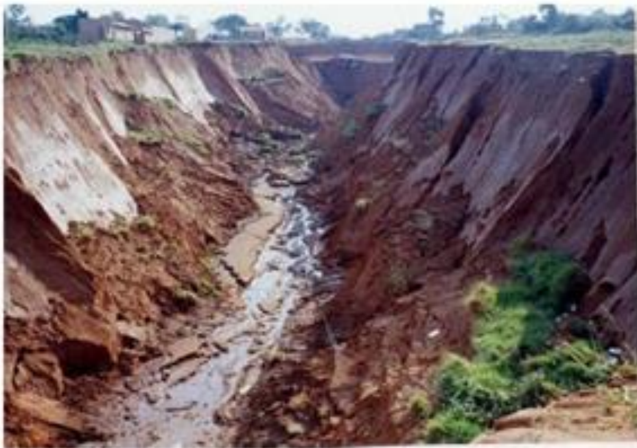
Figura 15: Escorregamentos dos taludes da boçoroca - ação do piping , Bauru (SP). Fonte: IPT, 2013
