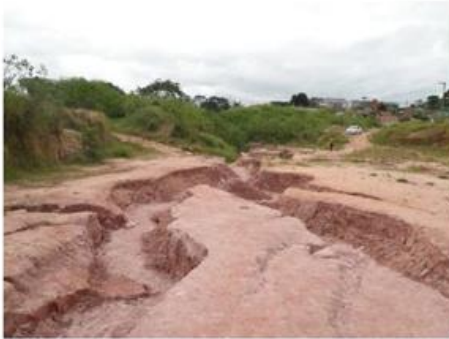
Figura 11: Ravinamento em área rural, município de Itaquaquecetuba (SP). Fonte: IPT, 2013
