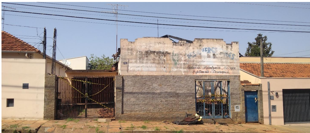
Fotografia 5: Fachada do “Imóvel D”
