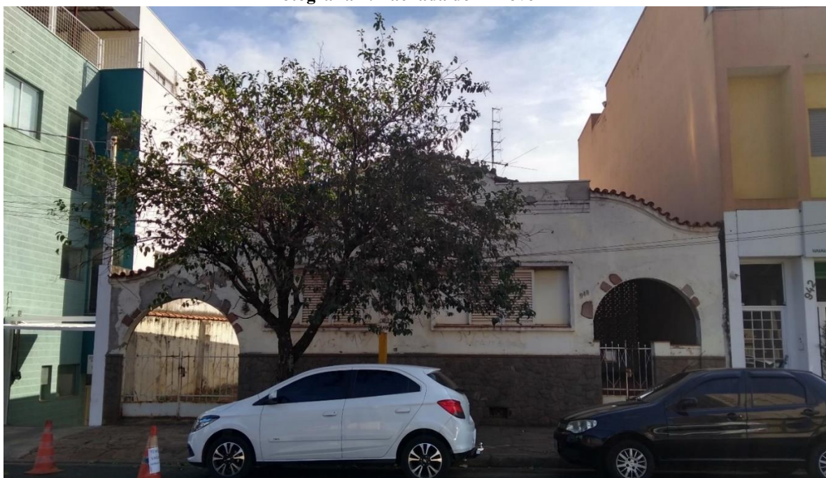
Fotografia 1: Fachada do “Imóvel A”
