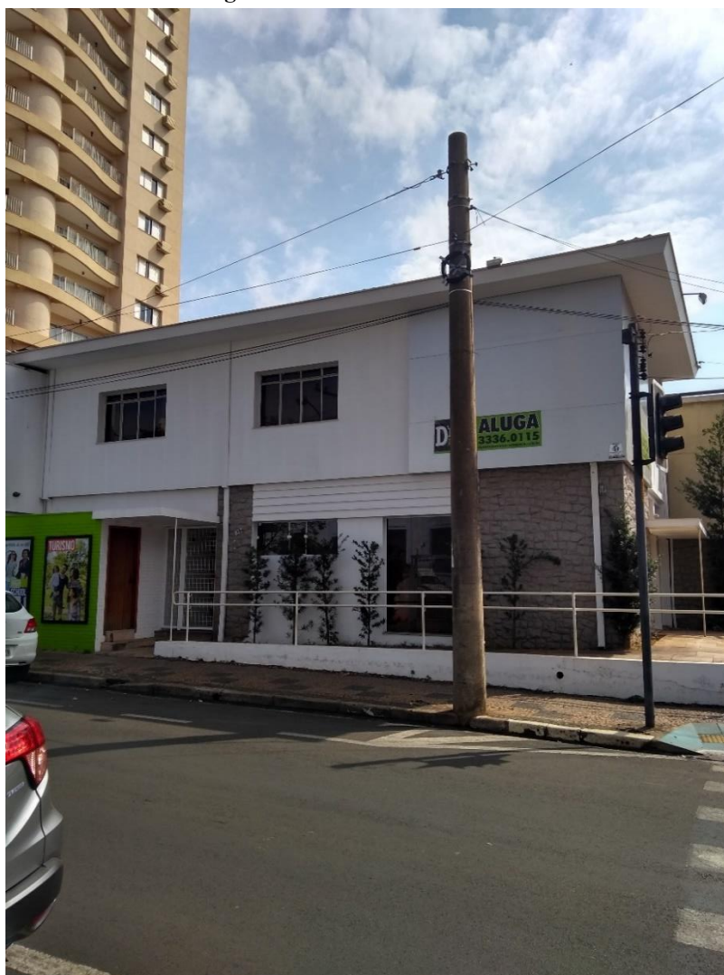
Fotografia 6: Fachada do “Imóvel C”
