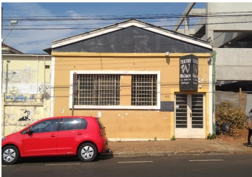
Fotografia 3: Fachada do “Imóvel E”
