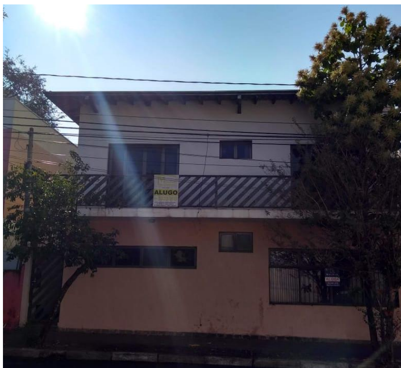
Fotografia 4: Fachada do “Imóvel F”
