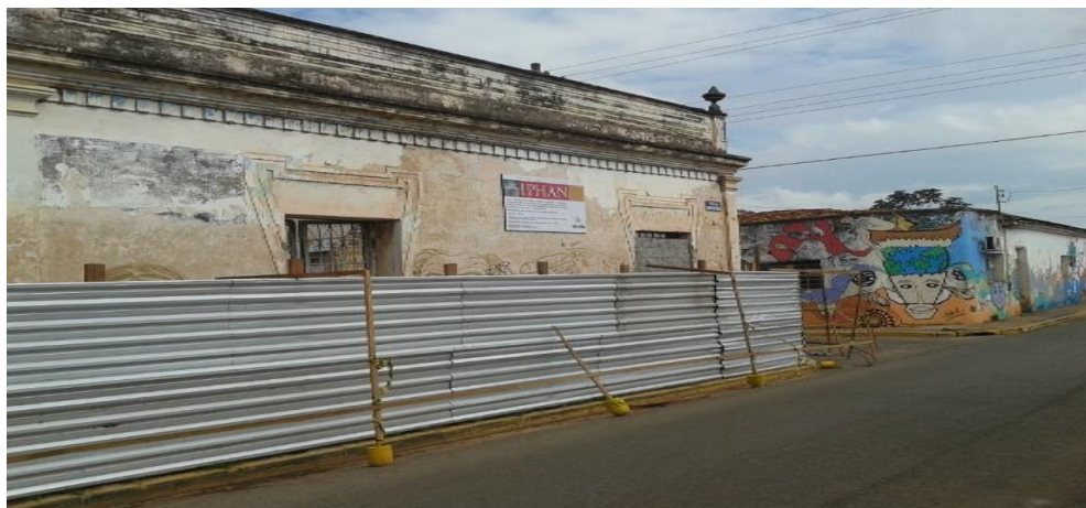
Figura 24 - Fachada Casa Pinho com placa do IPHAN
