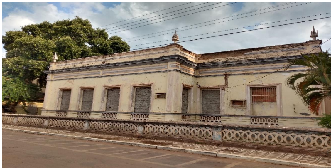
Figura 27 - Antiga Câmara - fachada lateral com janelas vedadas
