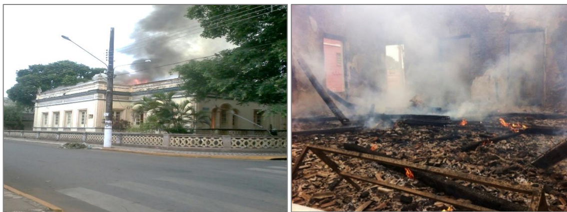
Figuras 34 (G e H) - Parte externa e interna do prédio em chamas 256
