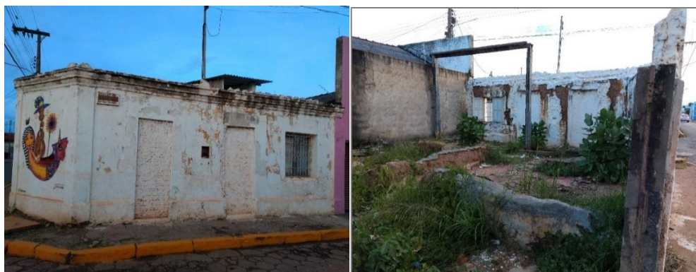
Figuras 26 (C e D) - Fachada e parte interna de casa com placa do IPHAN
