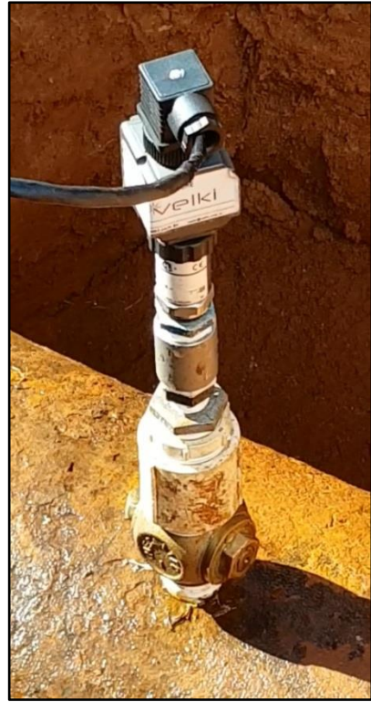
(b) Instalação do sensor de pressão
