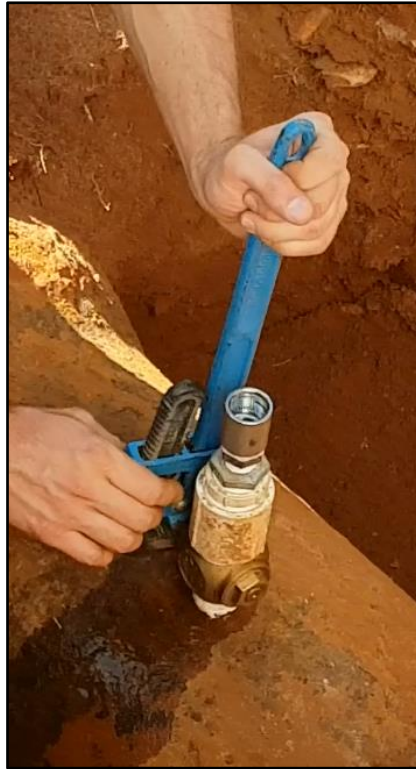
(a) Instalação do TAP
