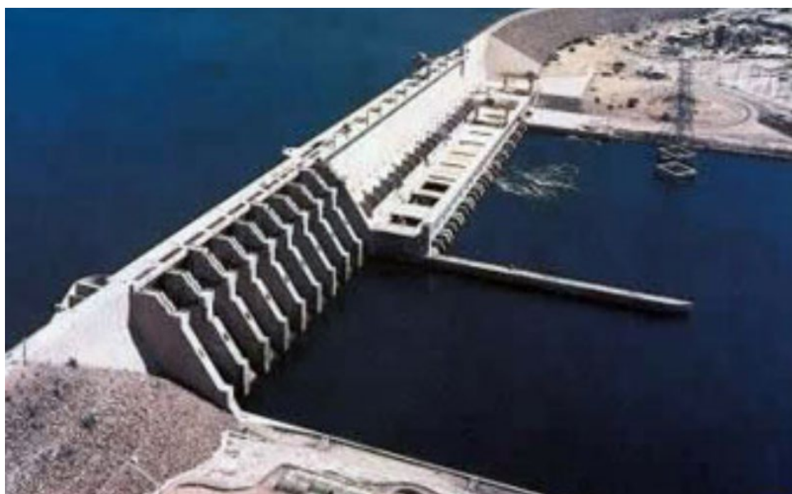
Figura 9 – O ‘monstro de concreto’: Barragem de Itaparica (Usina Hidrelétrica Luiz Gonzaga)
