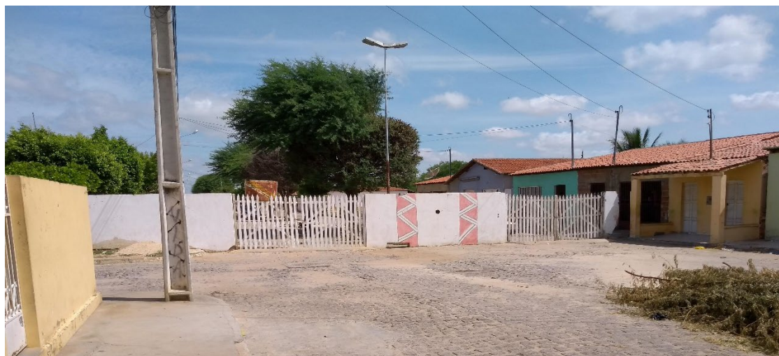
Figura 10 – Portões e muro que separam a Aldeia Mãe Tuxá da parte dos brancos em Rodelas
