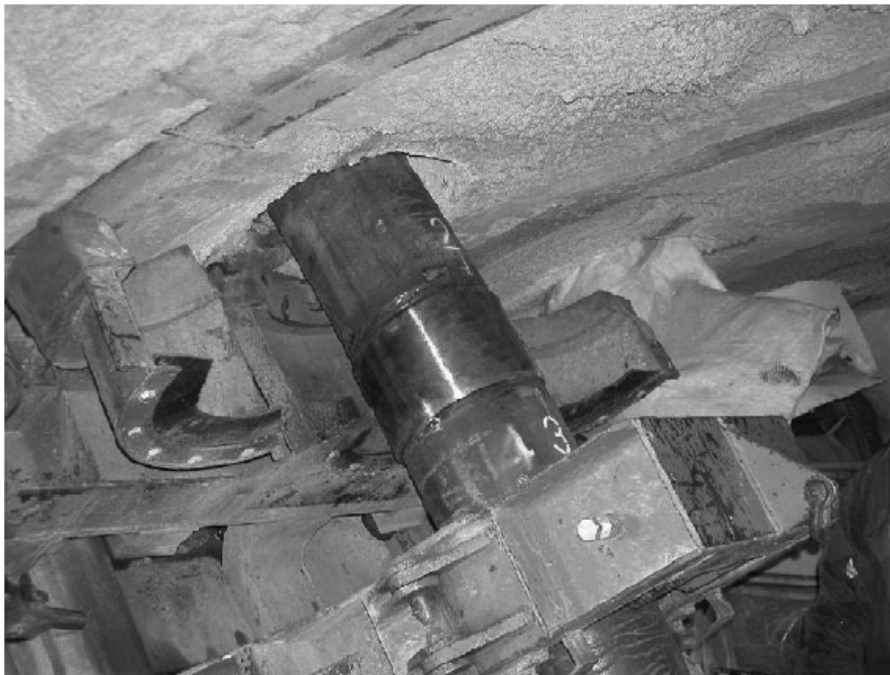
Figura 3.13 - Aplicação de tubos unidos por anel de metal com memória de forma [64].
