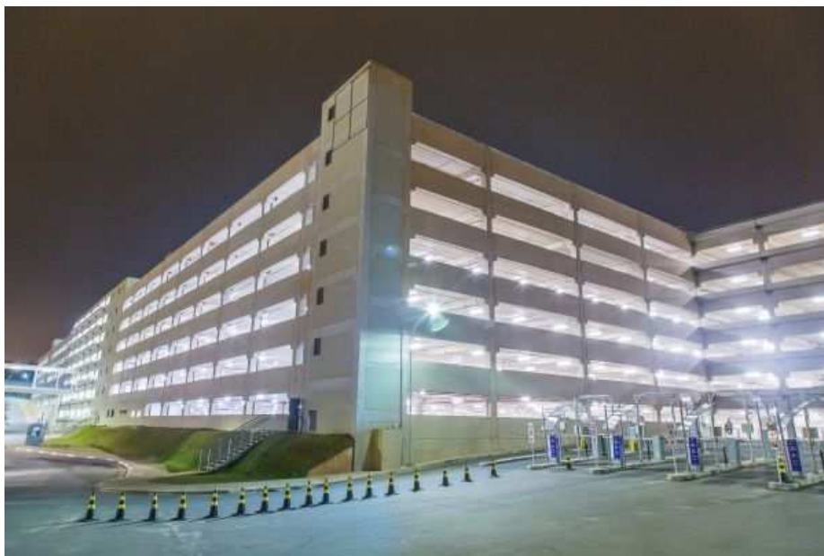
Figura 1. Edifício garagem em concreto pré-moldado (São Paulo Expo).
