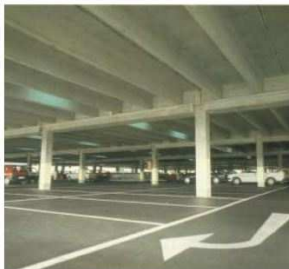
Figura 6. Laje duplo T em um edifício garagem.
