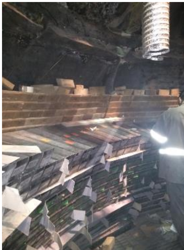
Figura 2-6 - Refratários MgO-C aplicado em fornos básicos de oxigênio
