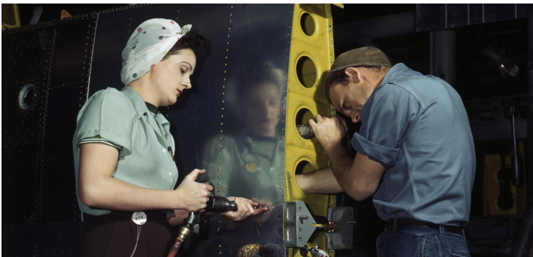
Figura 7: Operação de cravação de rebites de aviões na Segunda Guerra Mundial. Fonte: History (2017)
