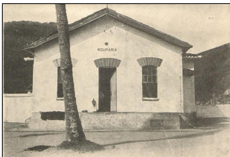
Figura 95 - Pavilhão da Rouparia (1939)
