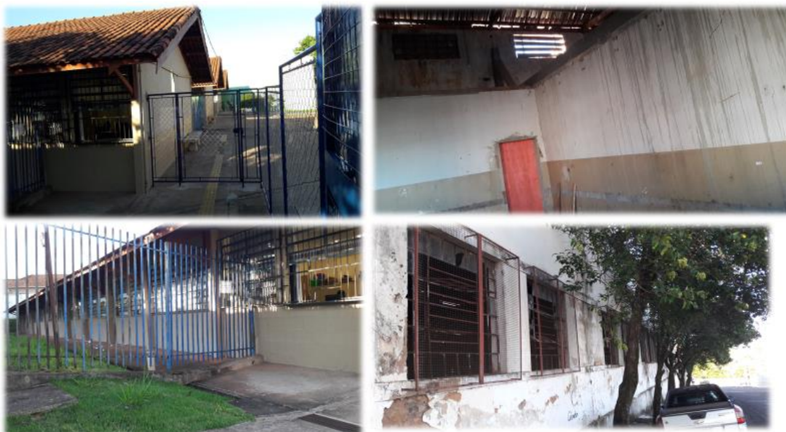
FIGURA 25 - Atual Escola Estadual Professor Francisco Silveira, construída ao lado após incêndio, no mesmo local
