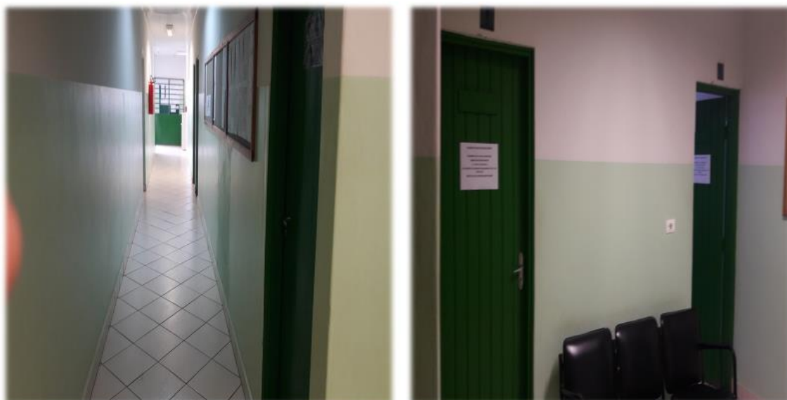
FIGURA 126 - Corredor das salas de direção, coordenação pedagógica, sala dos professores, secretaria acadêmica e sanitários, piso superior
