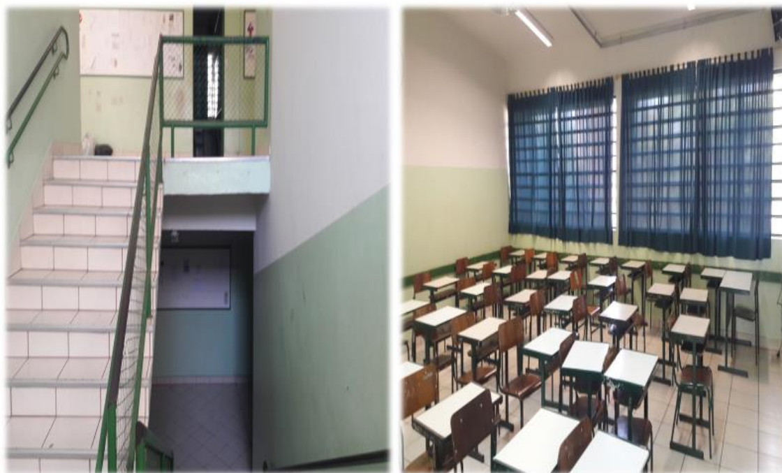
FIGURA 107 - Escadas para piso inferior e modelo de sala de aula
