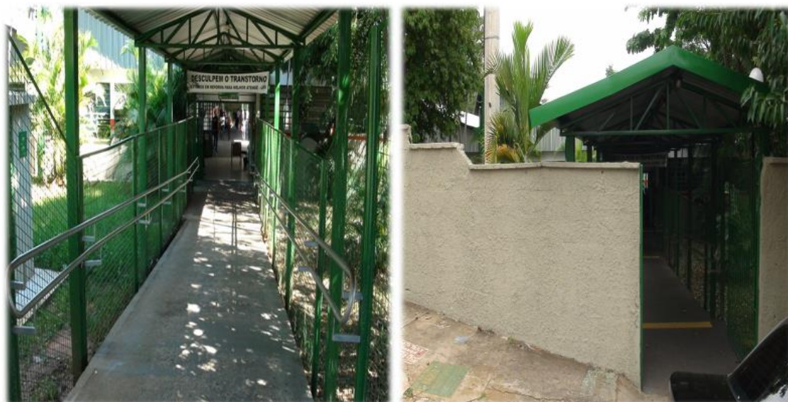
FIGURA 72 - Entrada principal da ETEC DANS, reforma 2012
