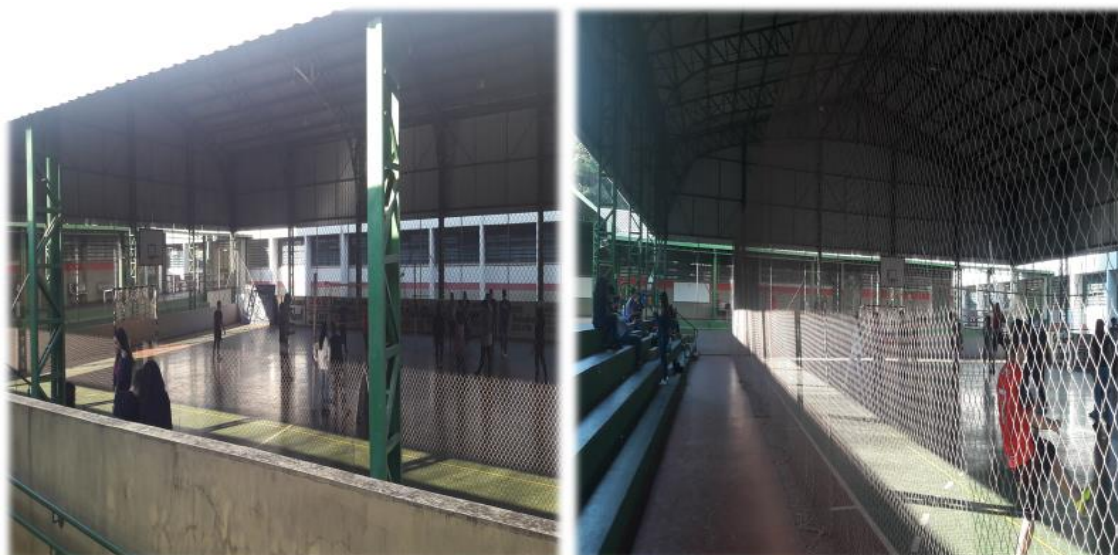
FIGURA 103 - Quadra poliesportiva coberta
