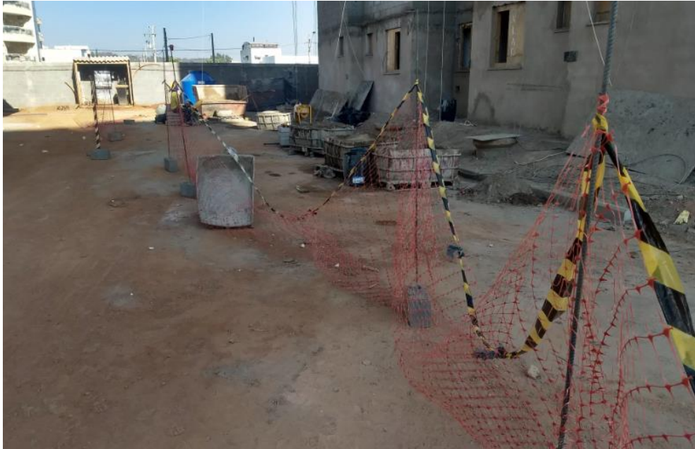
Figura 42 - Sinalização de área para execução de revestimento externo
