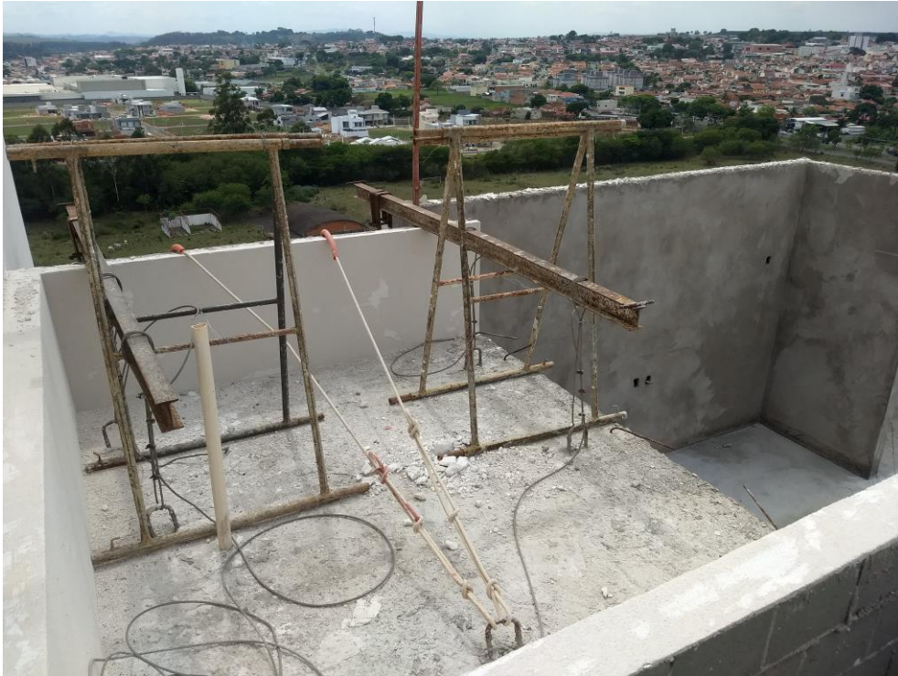
Figura 37 - Estrutura de suporte e espaçador dos balancins
