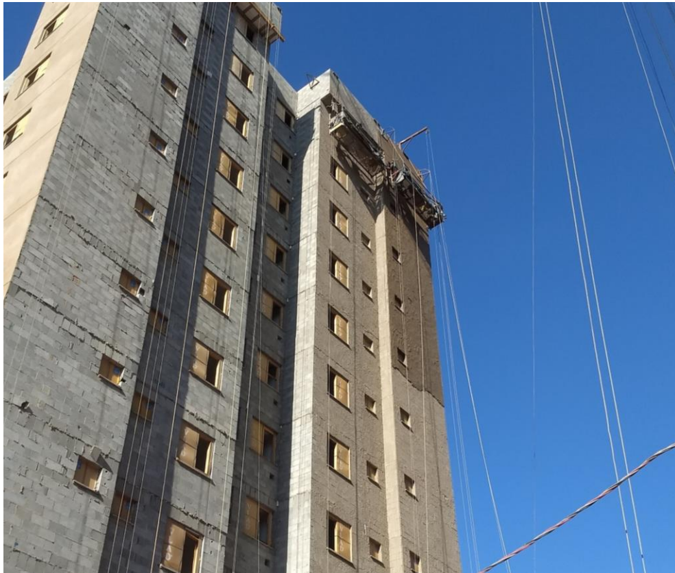
Figura 61 - Descida com aplicação de argamassa
