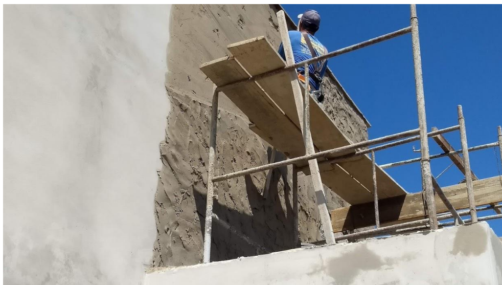
Figura 31 - Utilização de andaimes para revestimento do ático
