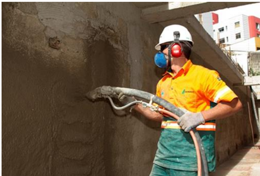
Figura 13 - Projeção de argamassa com uso de mangote
