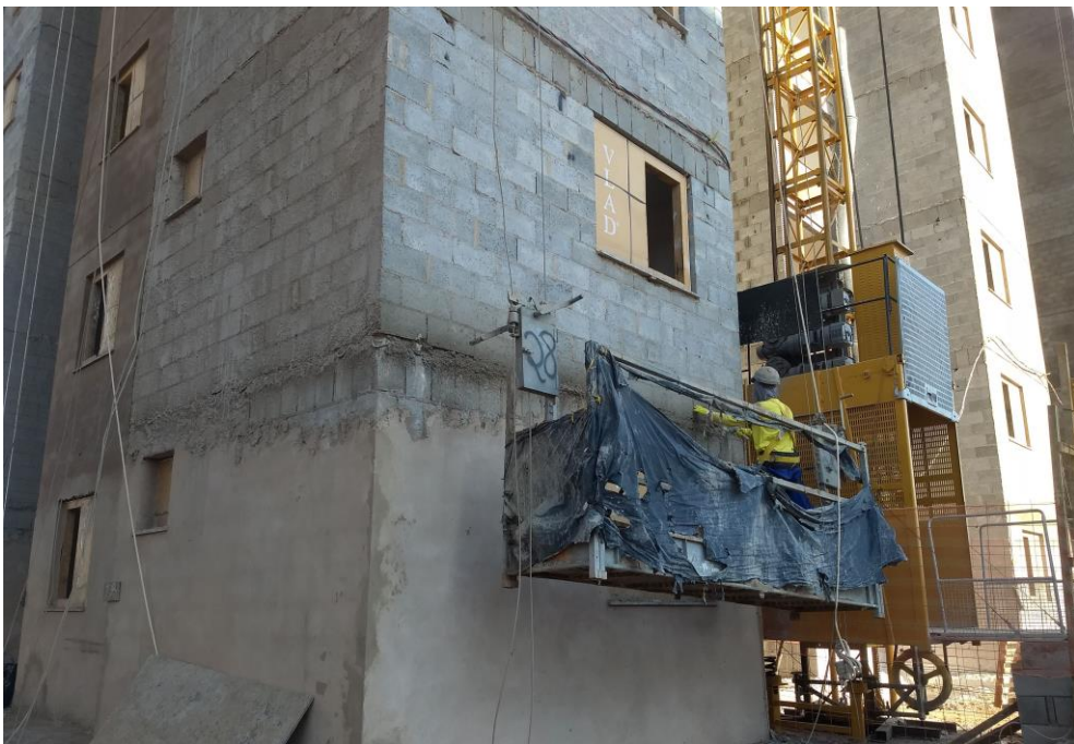
Figura 43 - Primeira subida, com limpeza da superfície e na descida são aplicadas as taliscas
