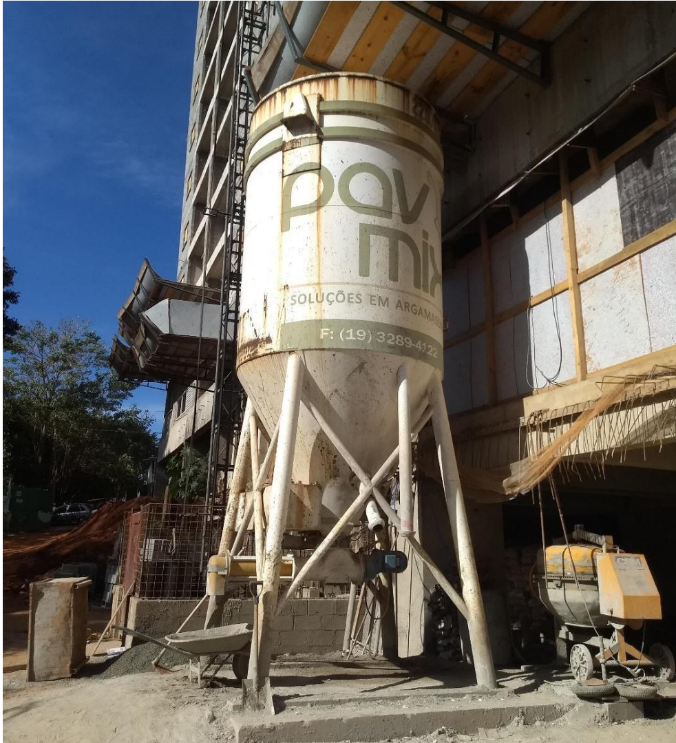
Figura 48 - Silo para armazenamento de argamassa a granel
