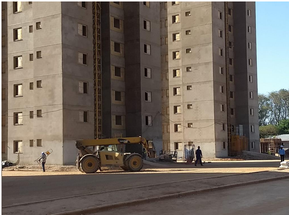
Figura 59 - Manipulador telescópico para movimentação horizontal de materiais
