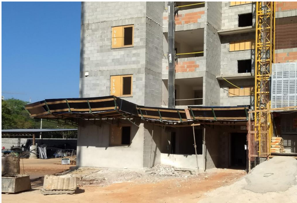
Figura 41 - Bandeja de segurança (EPC) para evitar a queda de materiais durante o levantamento de alvenaria
