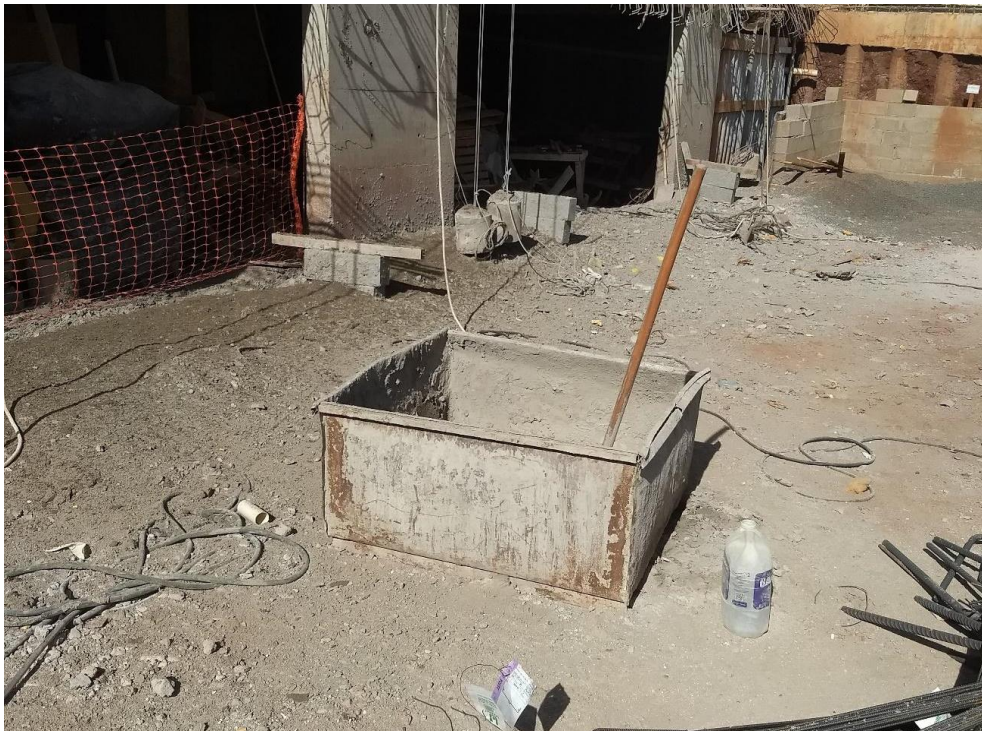
Figura 52 - Caixote intermediário para estoque temporário de argamassa
