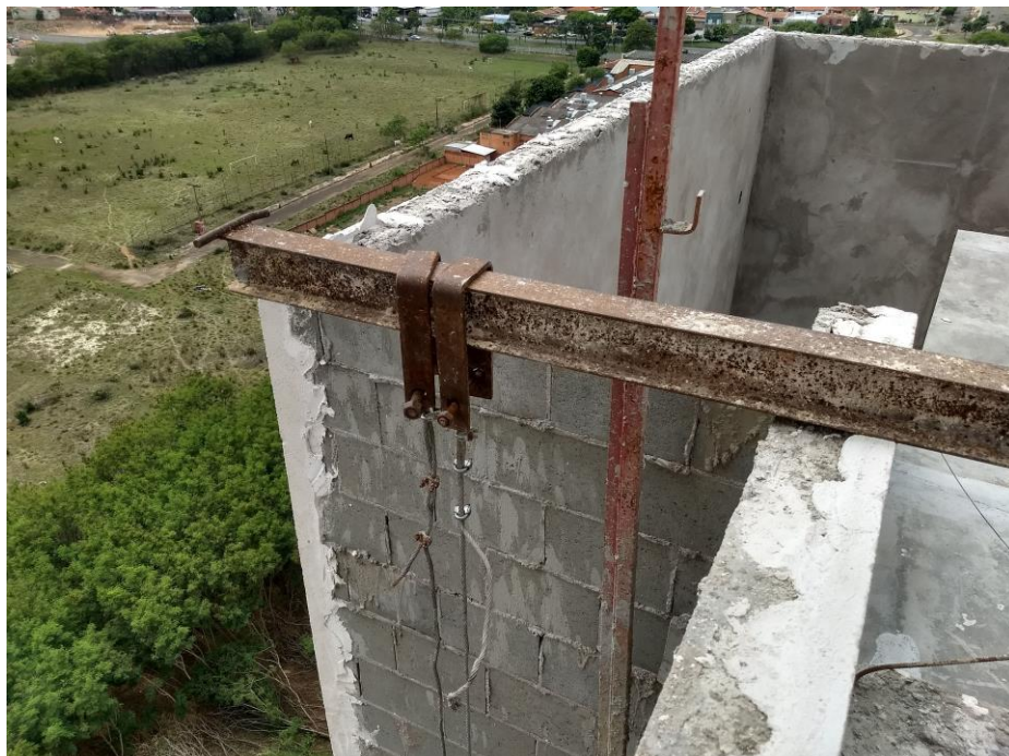
Figura 38 - O apoio do balancim se dá sobre a platibanda, que está grauteada
