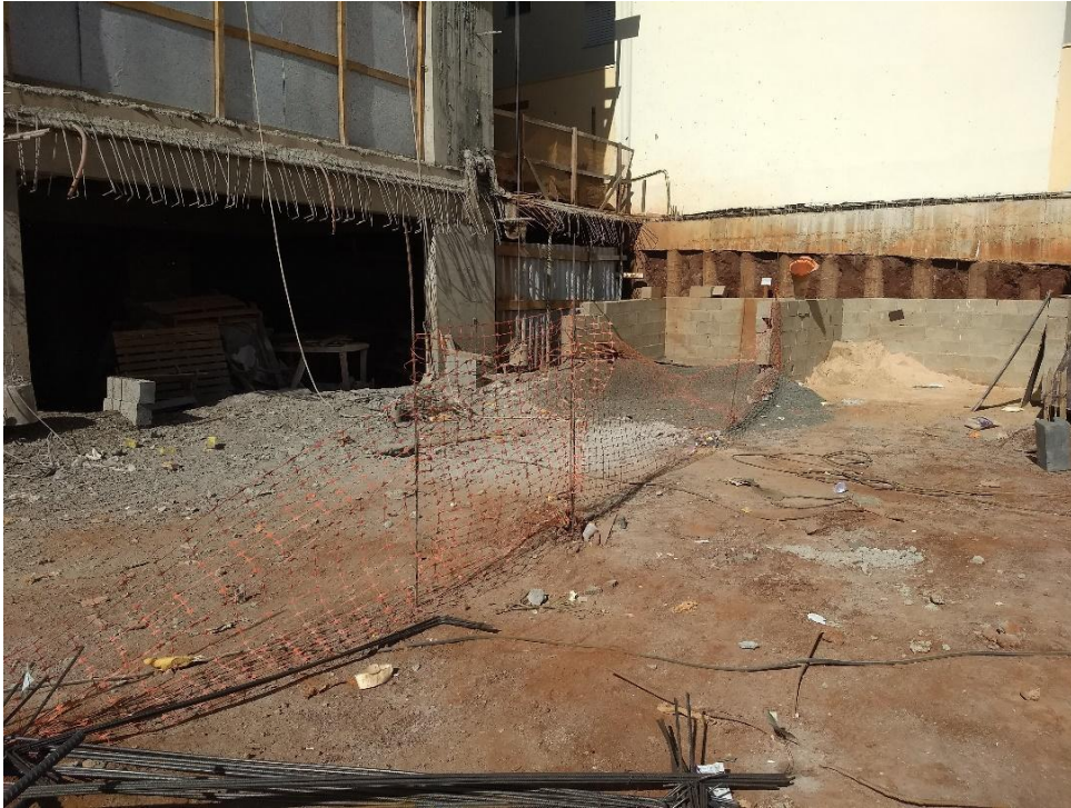
Figura 39 - Sinalização de área para execução do revestimento externo
