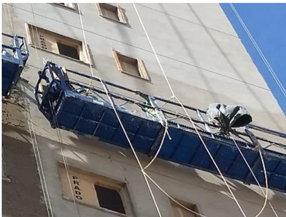
Figura 30 - Balancim onde é possível observar duas linhas de vida.
