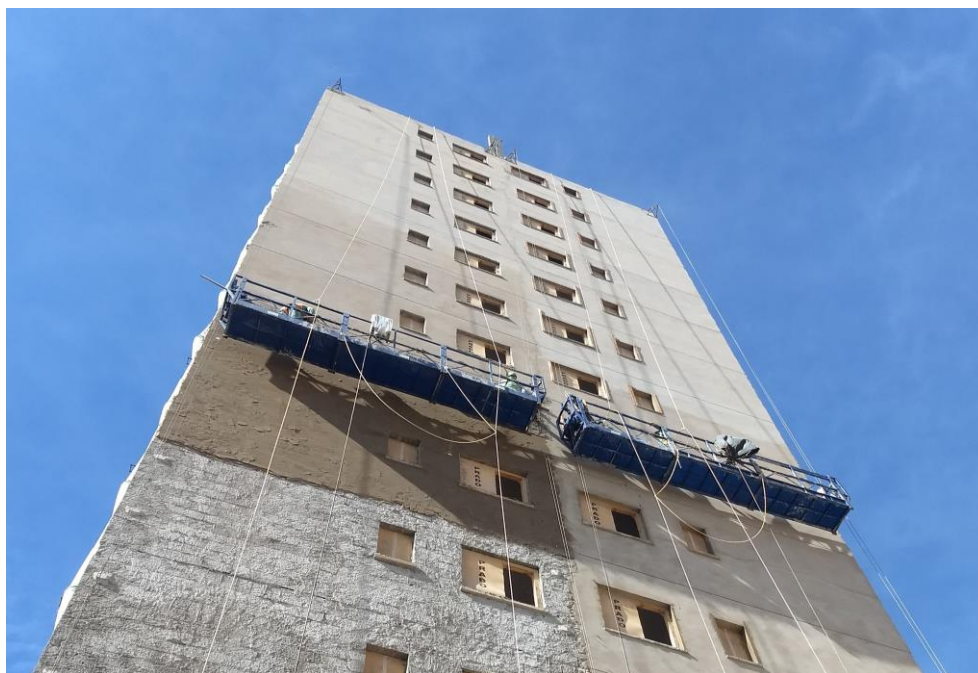
Figura 53 - Descida com aplicação de argamassa
