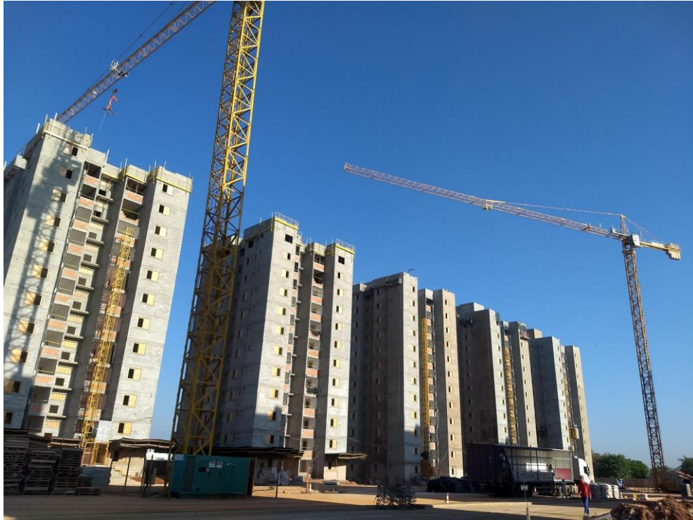
Figura 58 – Gruas utilizadas para transporte horizontal e vertical de materiais
