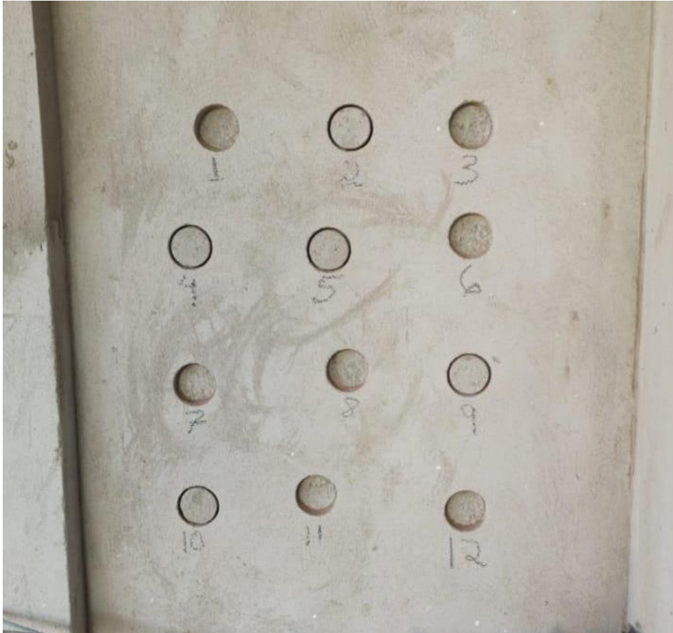
Figura 49 - Teste de arrancamento para determinar a tensão suportada do revestimento
