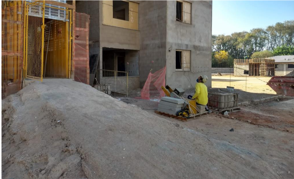
Figura 60 - Ajudante elevando argamassa com uso da talha para o oficial encher a masseira que utiliza para aplicação
