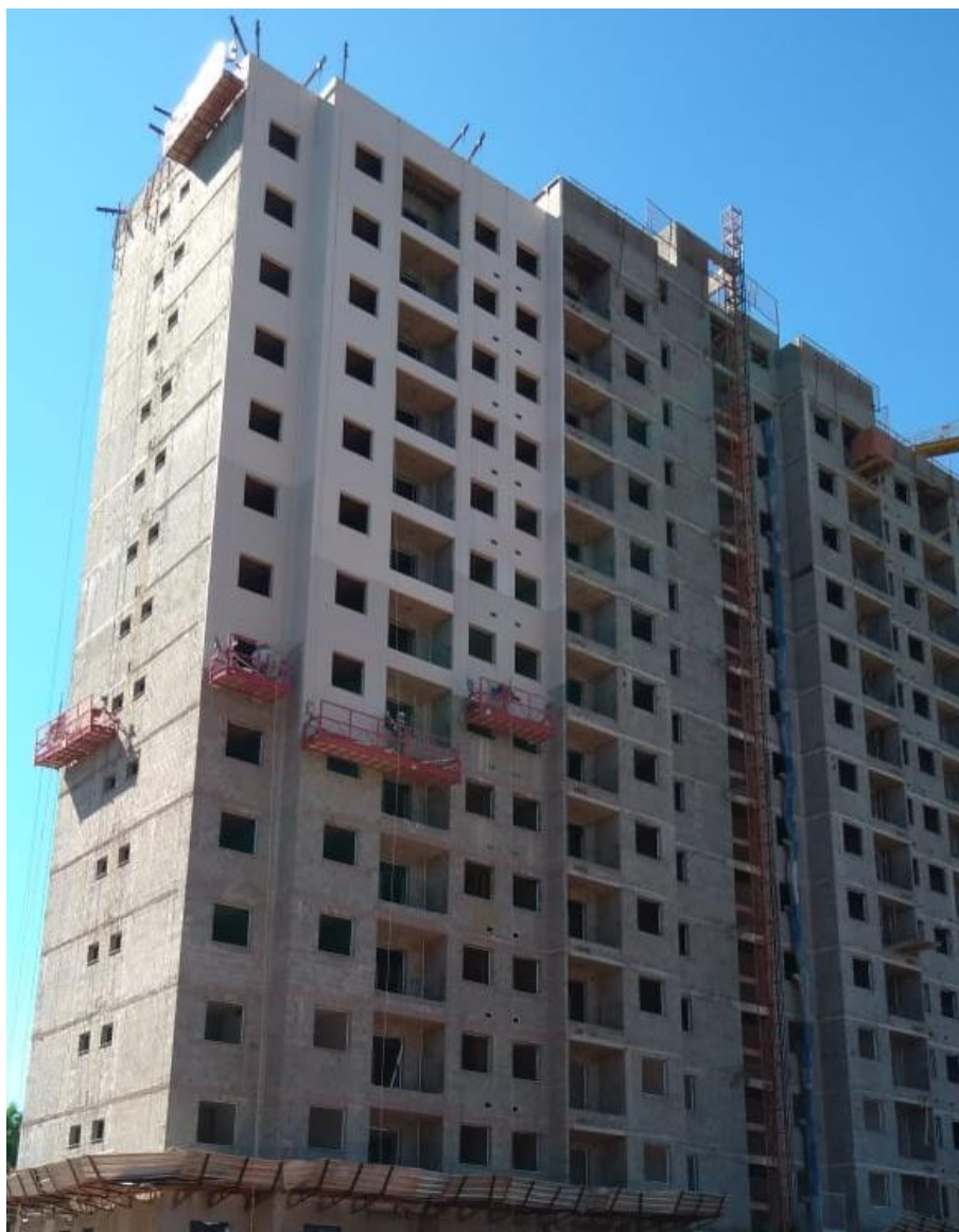
Figura 69 - Execução da fachada do edifício
