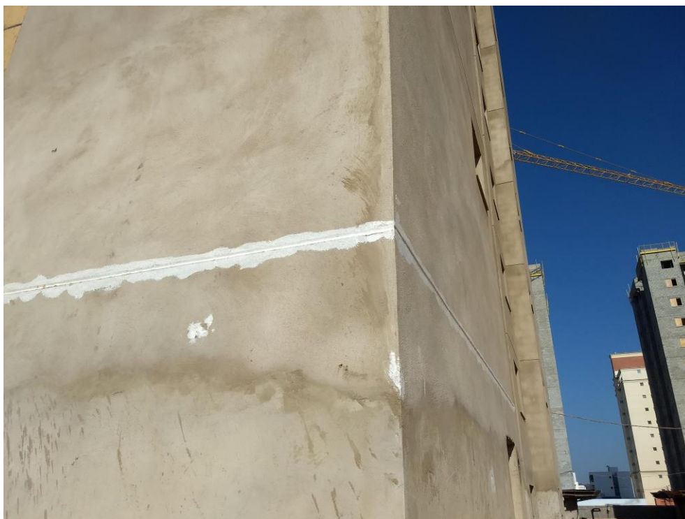
Figura 70 - Tratamento das juntas de trabalho com adesivo de Poliuretano (PU)
