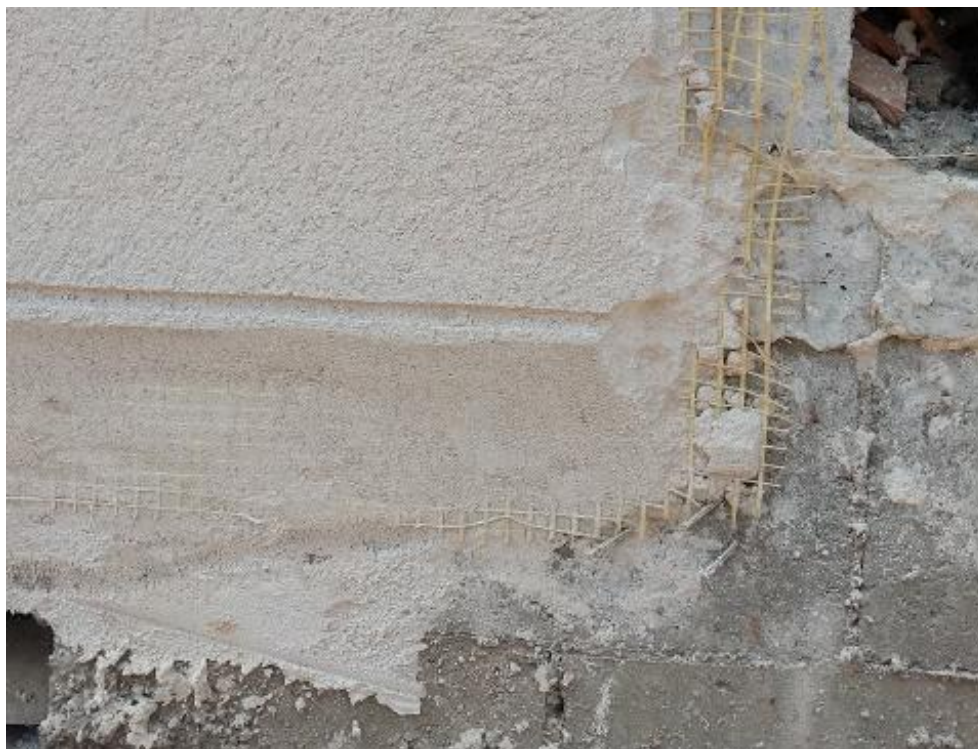
Figura 73 - Reforço com fibra de vidro utilizado no revestimento do primeiro e último pavimento
