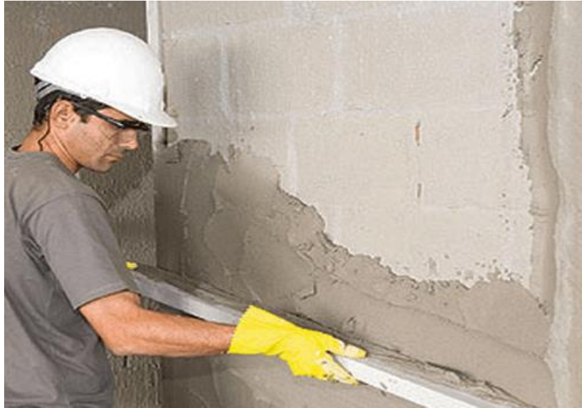
Figura 14 - Sarrafeamento com uso de régua metálica
