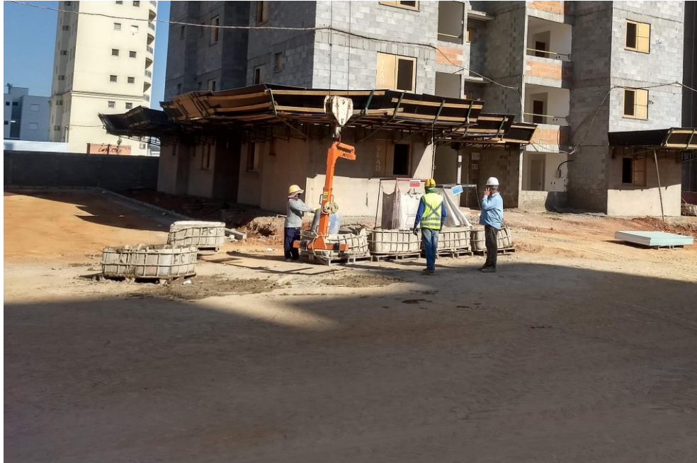
Figura 54 - Recipientes de argamassa estabilizada recebidos e preparados para transporte com grua e manipulador telescópico
