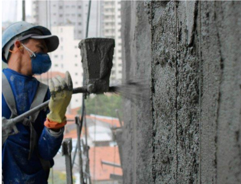
Figura 12 - Projeção de argamassa a ar comprimido
