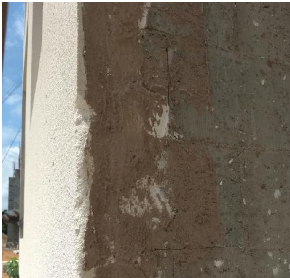
Figura 46 - Aplicação de chapisco rolado na união de revestimento
