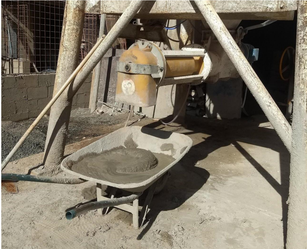
Figura 51 - Carriola sendo enchida com argamassa
