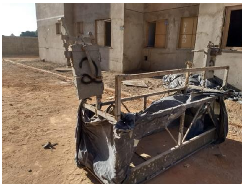
Figura 32 - Balancim utilizado no empreendimento com catraca manual
