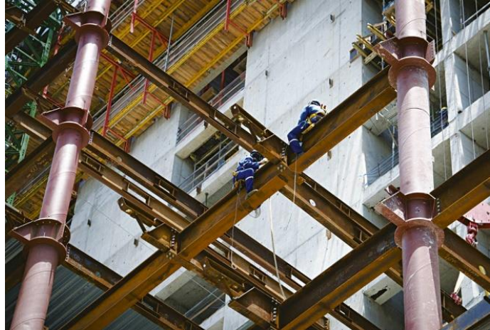
Figura 1.3: Obras de edifícios com pilares mistos preenchidos circulares
