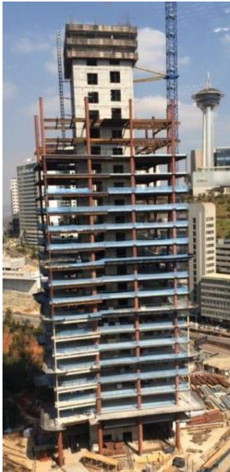
Figura 1.3: Obras de edifícios com pilares mistos preenchidos circulares
