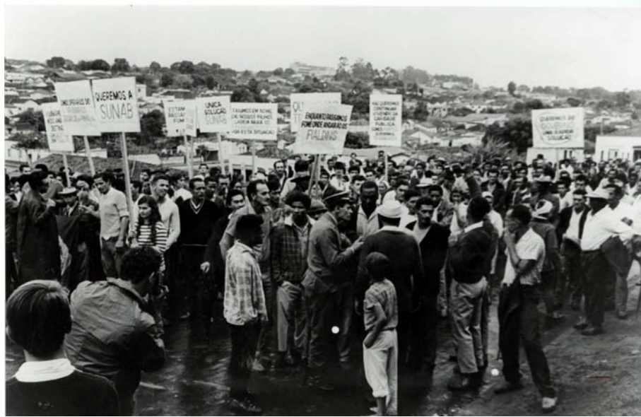
Greve dos Trabalhadores do Frigorífico São Carlos do Pinhal em 1968
