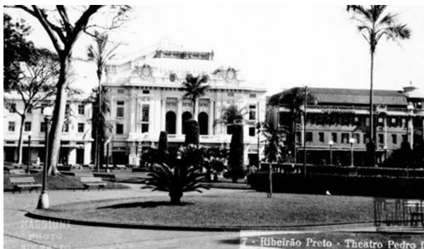
Figura 35: Foto da Praça XV de Novembro, teatro Pedro II, edifício Meira Júnior e Central Hotel (posteriormente denominado de Palace Hotel, Atualmente Quarteirão Paulista - 1930).
