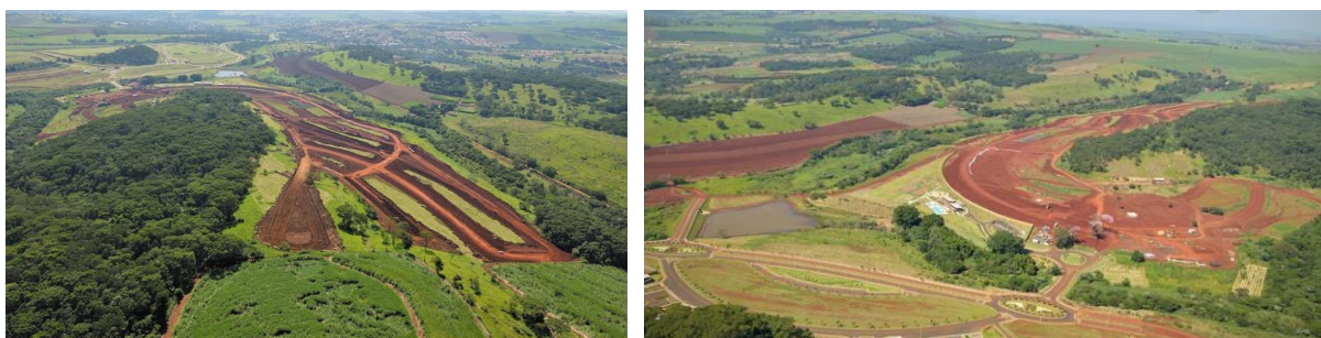
Figura 200a: Obras para a implantação do empreendimento Alphaville Ribeirão Preto fases 1, 2 e 3.
