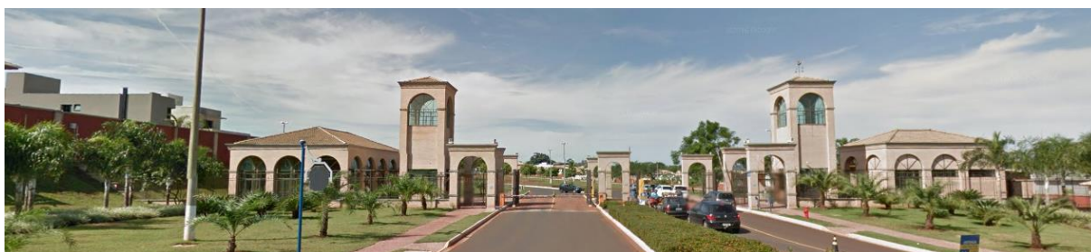
Figura 125: Imagem da guarita do loteamento Nova Aliança Sul – Subsetor Sul 10.
