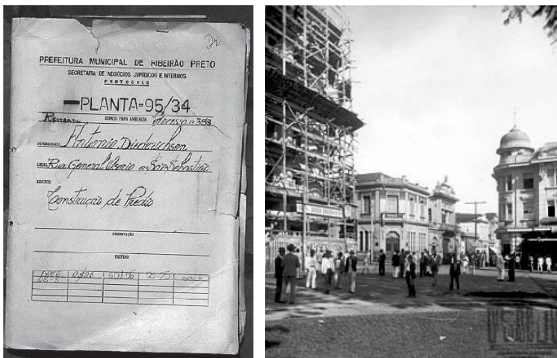
Figura: 34a – Documento do processo de aprovação do primeiro edifício verticalizado da cidade de Ribeirão Preto, à esquerda.
