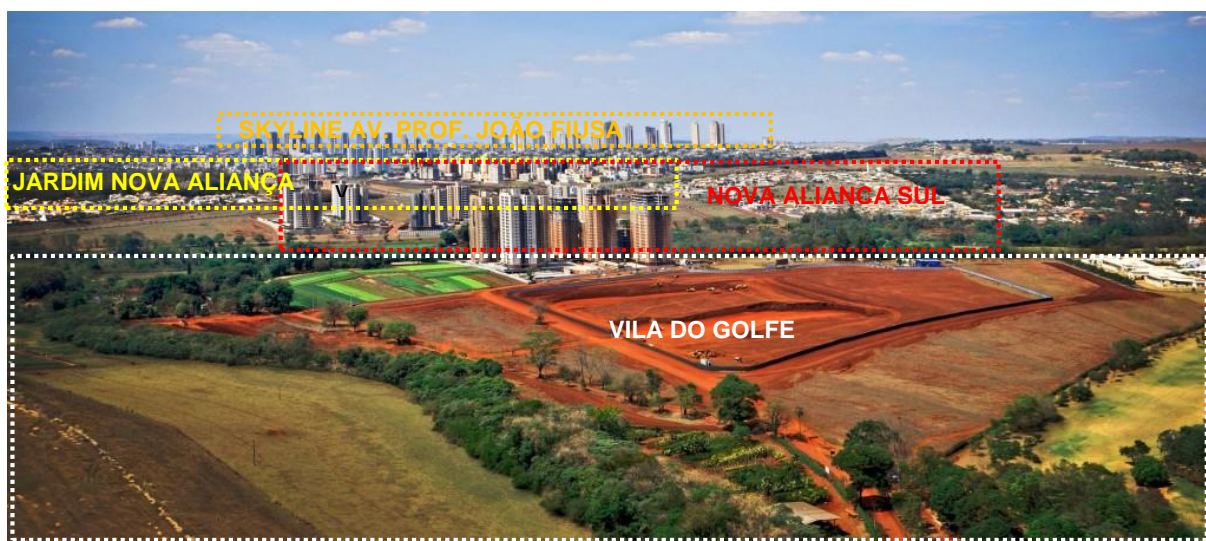
Figura 198: Empreendimento Vila do Golfe – Obras de infraestrutura para Implantação do Shopping Iguatemi. Ao fundo, empreendimento Nova Aliança Sul, Nova Aliança e Skyline da avenida professor João Fiusa. no subsetor Sul-10.
