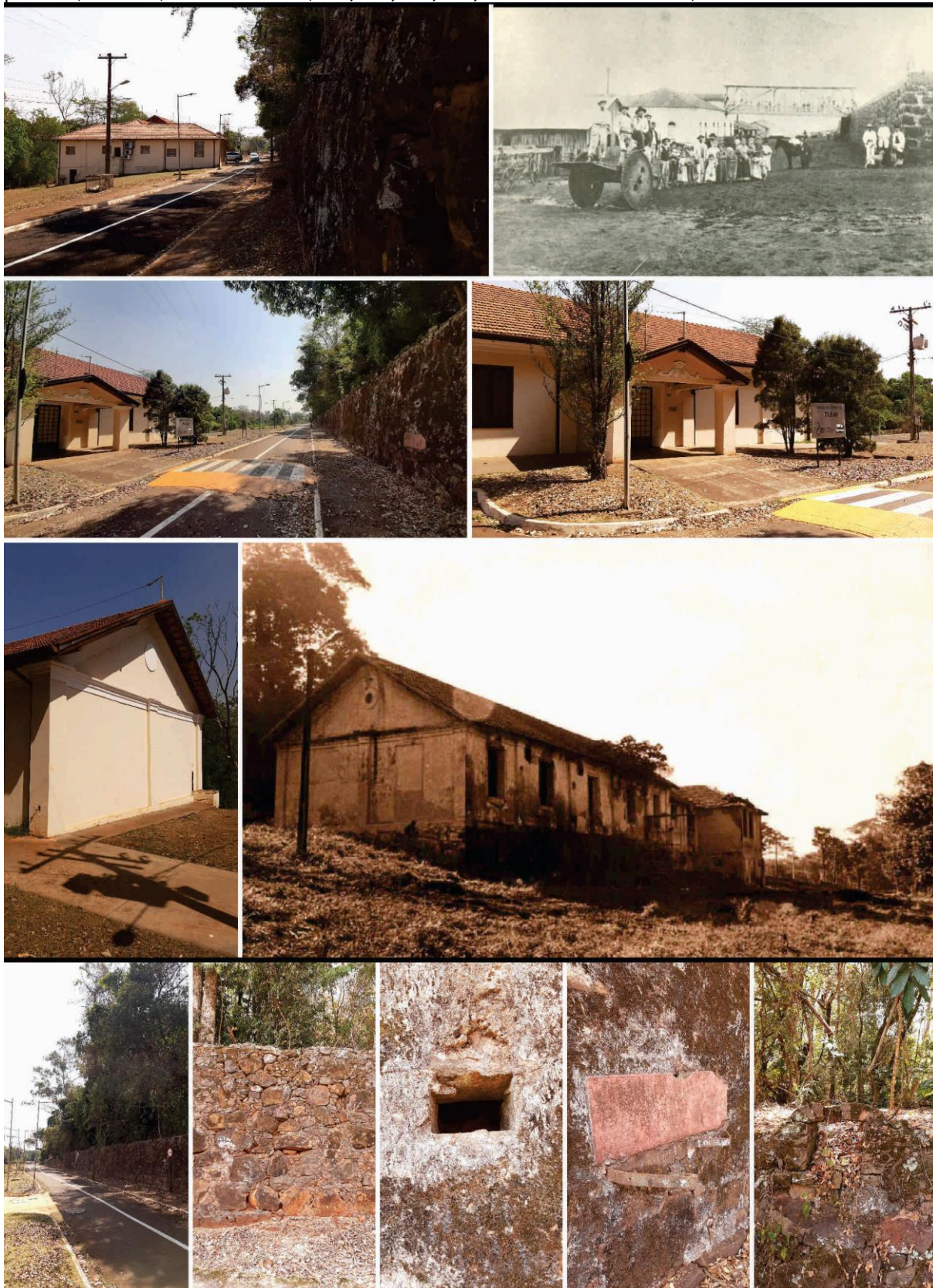
Figuras 181, 182, 183 – Terreiro (amurada da extremidade inferior) e tulha da Fazenda Monte Alegre, em 2020, 1896 e 2020; 184, 185, 186 – Tulha da Fazenda Monte Alegre – vistas frontal, lateral direita e lateral direita mais posterior, em 2020, 2019 e sem data; 187, 188, 189, 190, 191 – Terreiro e detalhes, em 2020.
