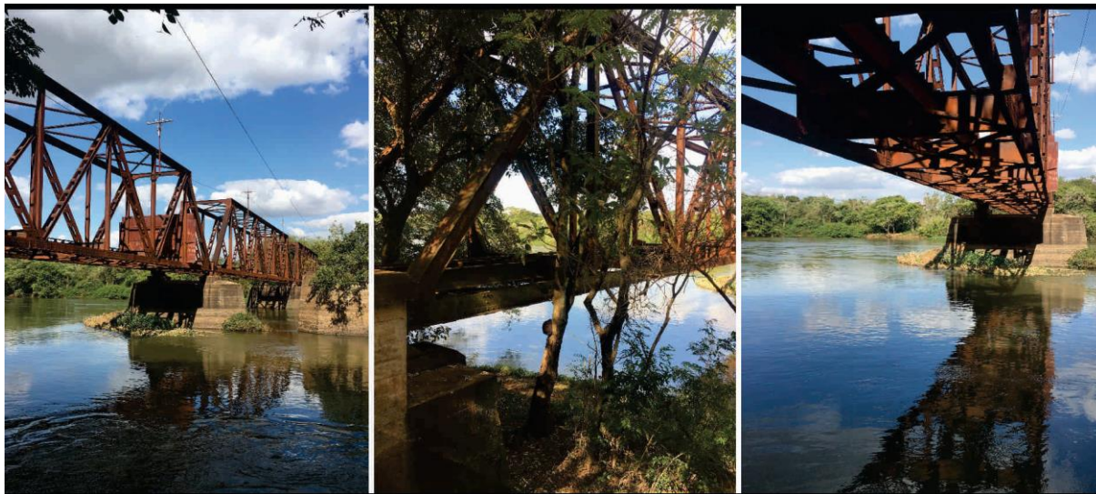
Figura 282 – Pontes do Rio Pardo de 1886 (à direita, pilar visível) e 1930 (esquerda), Companhia Mogiana (CM), em 2019; 283, 284 – Ponte do Rio Pardo de 1930, CM, em 2019
