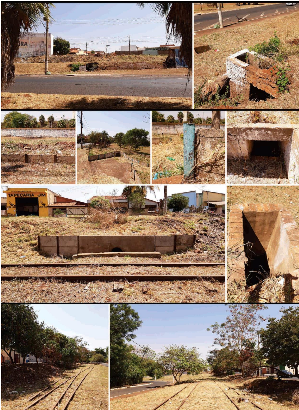
Figuras 89, 90 – Bueiro de águas pluviais fechado 1, FEPASA, em 2020; 91, 92, 93, 94, 95, 96 – Bueiro de águas pluviais fechado 2, FEPASA, em 2020; 97 – Aparelho de mudança de via entre Linha do Rio Grande (direita) e Ramal do Sertãozinho (esquerda), da Companhia Mogiana, em 2020; 98 – Linhas férreas da Linha do Rio Grande (esquerda) e Ramal do Sertãozinho (direita), em 2020.
