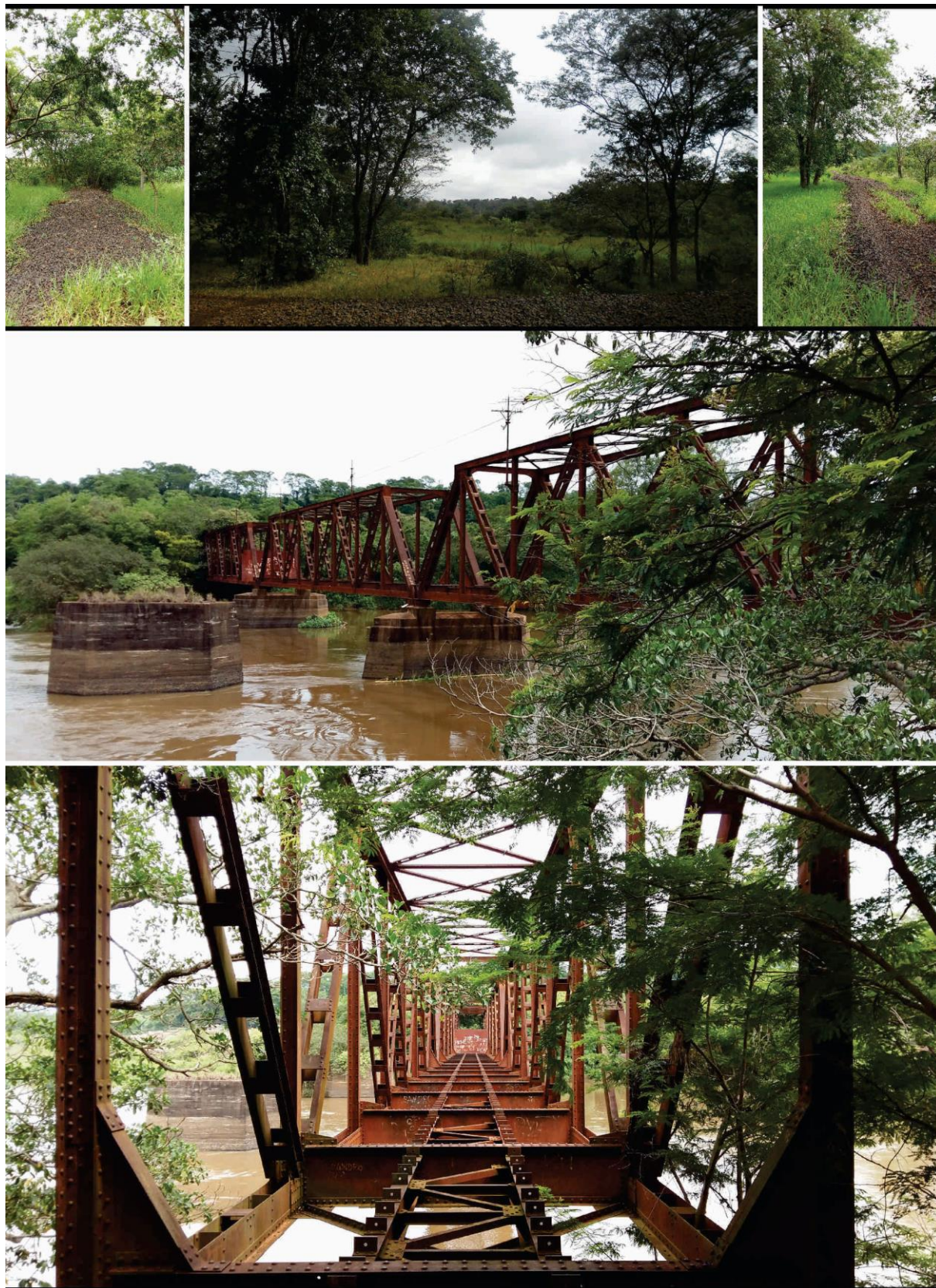
Figuras 277, 278, 279 – Faixa de domínio da Linha do Rio Grande, Companhia Mogiana (CM), com via férrea muito alterada, em 2018; 280 – Pontes do Rio Pardo de 1886 (à esquerda, pilar visível) e 1930 (direita), CM, em 2018; 281 – Superestrutura da Ponte do Rio Pardo de 1930, CM, em 2018.
