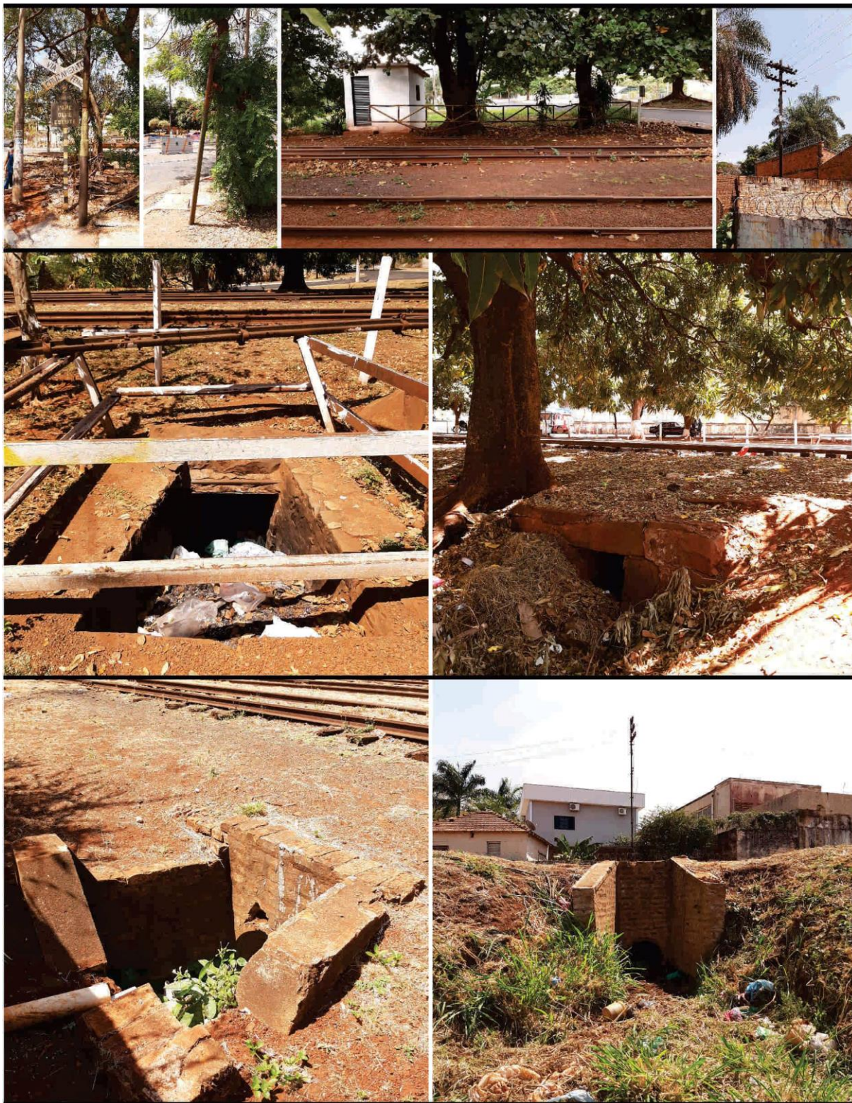
Figuras 105, 106, 107, 108 – Mobiliário ferroviário – sinalizações verticais, cancela, poste telegráfico, em 2020; 109, 110 – Bueiro de águas pluviais fechado 5, CM, em 2020; 111, 112 – Bueiro de águas pluviais fechado 6, FEPASA, em 2020.
