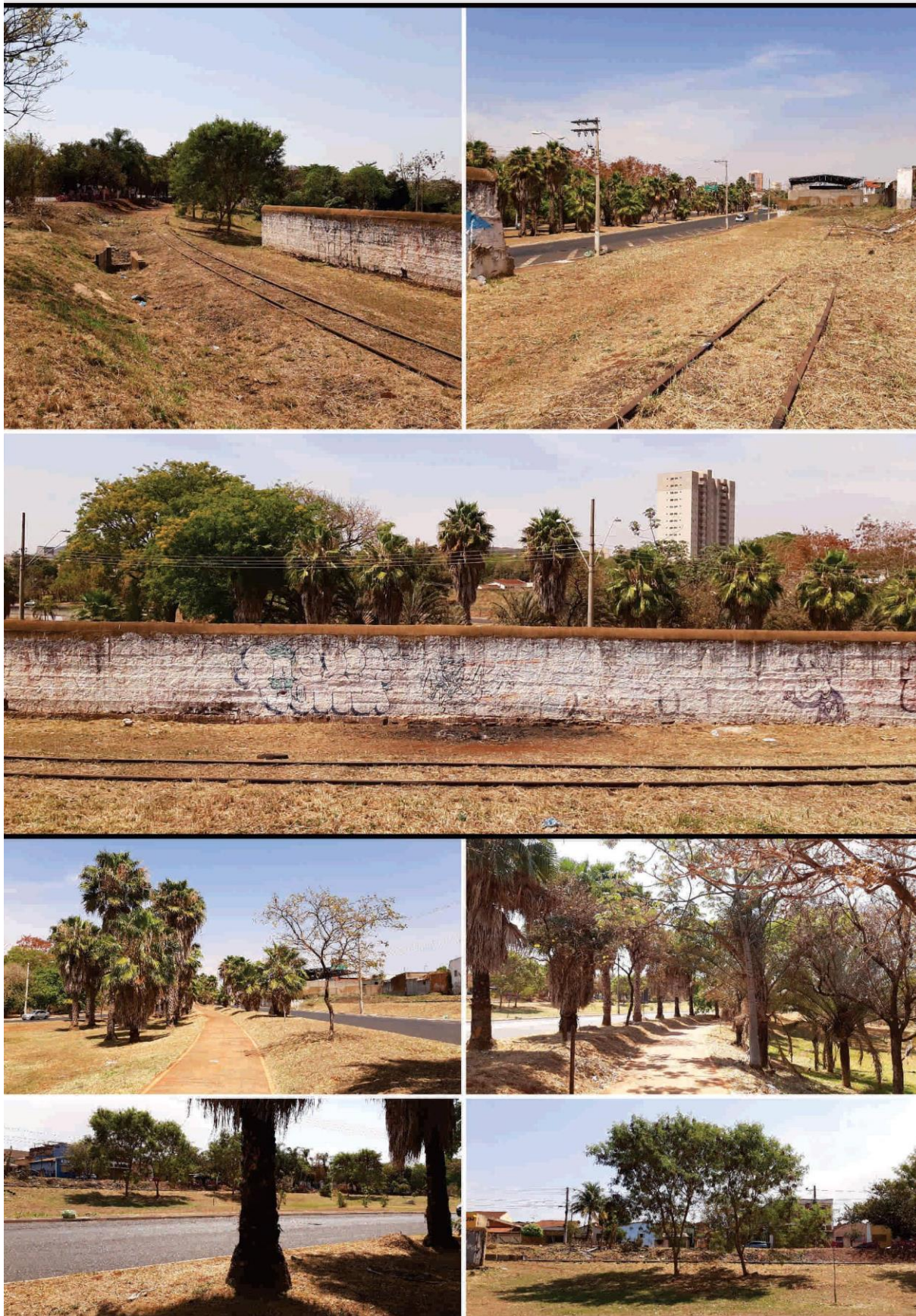
Figuras 82, 83, 84 – Faixa de domínio da Linha do Rio Grande, da Companhia Mogiana, pouco alterada, em 2020; 85, 86 – Parque Linear Via Norte, em 2020; 87, 88 – Vistas da faixa de domínio da Linha do Rio Grande a partir do Parque Linear Via Norte, em 2020.
