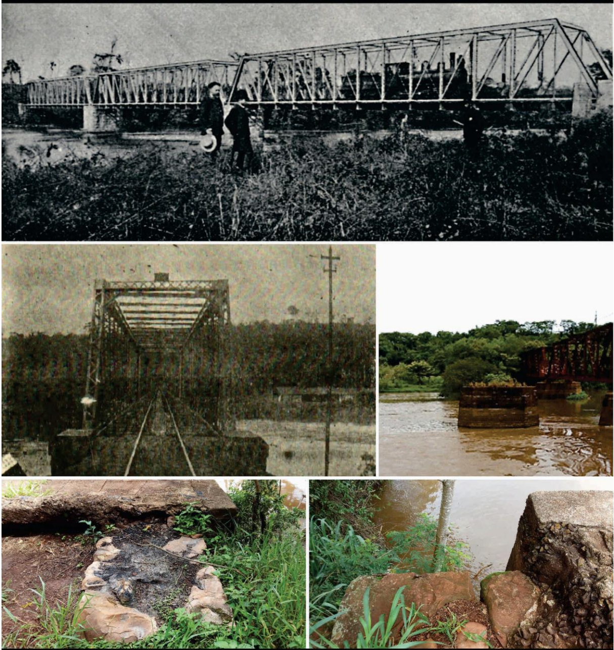
Figura 272, 273 – Ponte do Rio Pardo de 1886, Companhia Mogiana (CM), íntegra, em 1895 e 1913; 274 – Ponte do Rio Pardo de 1886 (pilar visível), CM, descaracterizada e arruinada, em 2018; 275, 276 – Detalhes do encontro da Ponte do Rio Pardo de 1886, CM, em 2018.
