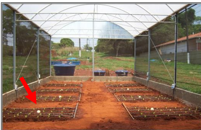
Figura 5 - Casa de vegetação após a instalação do sistema de gotejamento e das sondas EnviroSCAN ®* no centro das parcelas.
