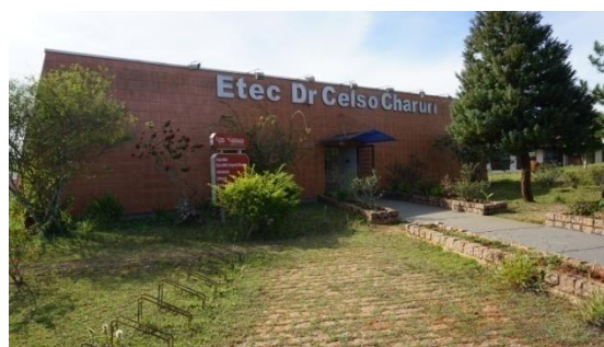
FIGURA 8 – Fachada Frontal da ETEC Dr. Celso Charuri
