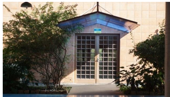
FIGURA 12 - Bloco A de Salas de Aula
