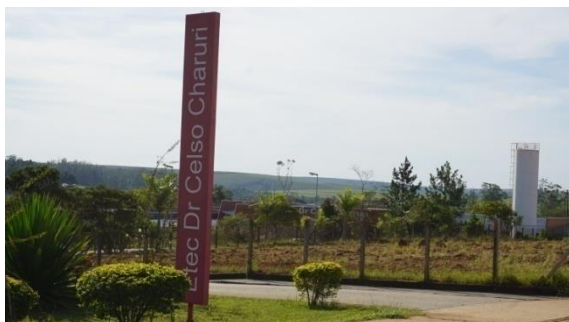
FIGURA 5 – Acesso à entrada da ETEC Dr. Celso Charuri
