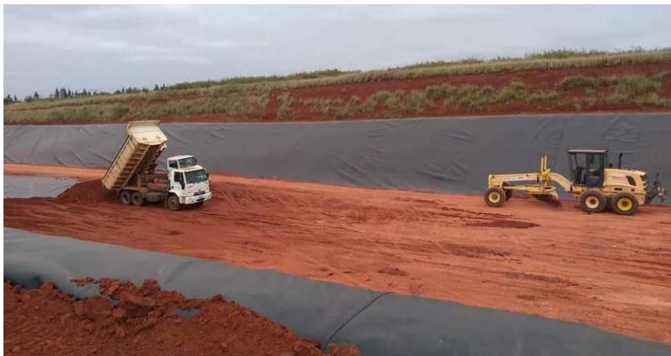
Figura 8 – Obras do aterro sanitário de Itapeva (2020)
