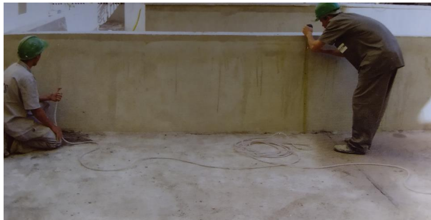
Figura 8: Transferência de nível com mangueira
