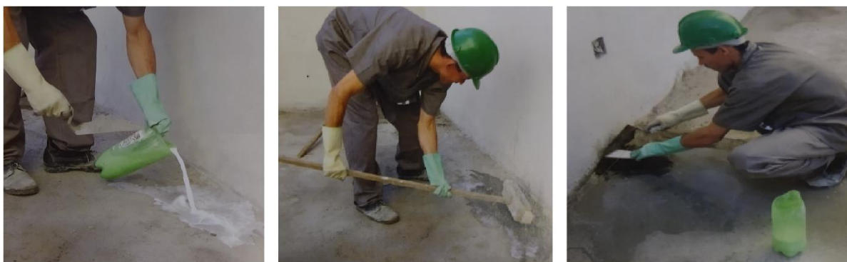
Figura 10: Aplicação da mistura adesiva e execução das taliscas
