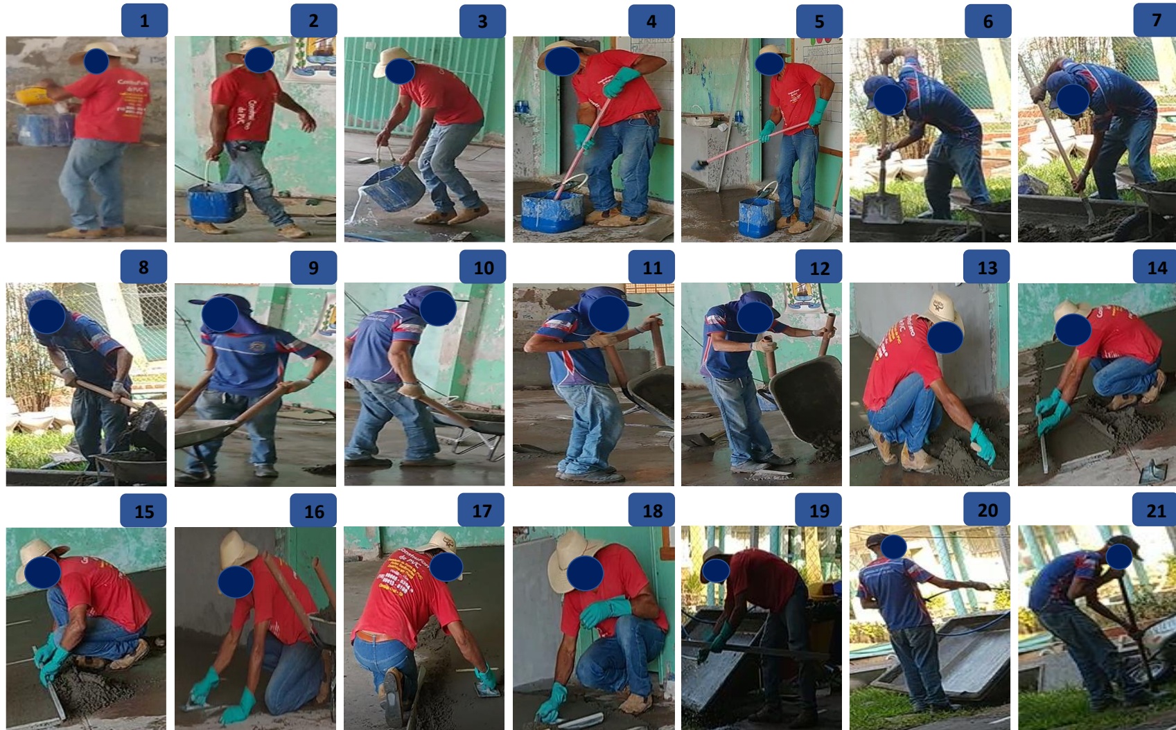
Figura 43: Resultados REBA – execução da camada de contrapiso
