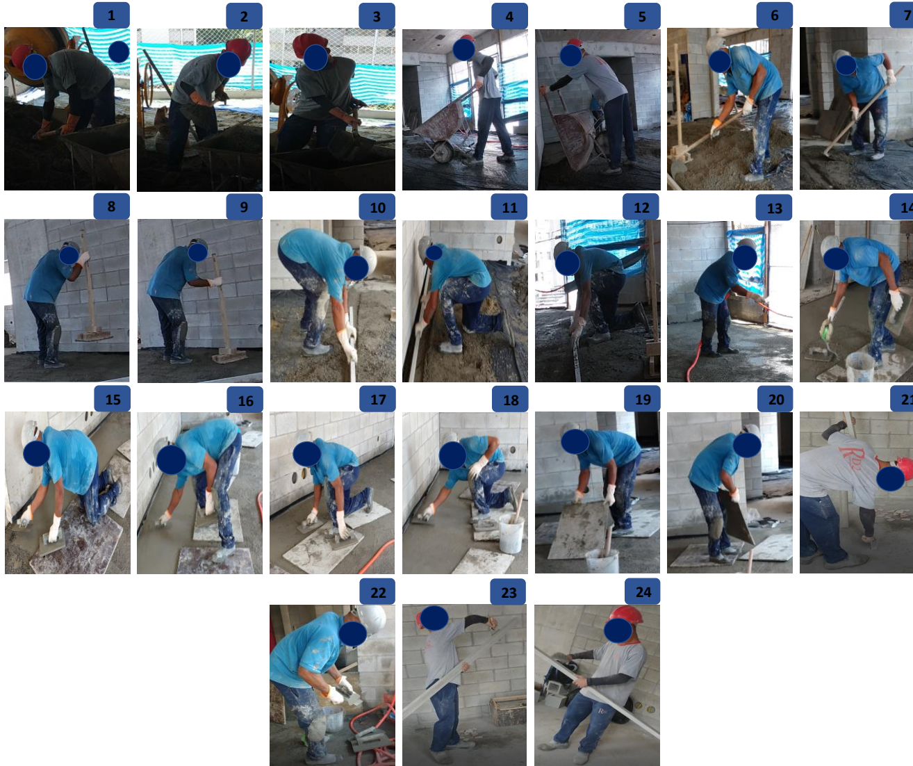
Figura 35: Posturas – execução da camada de contrapiso
