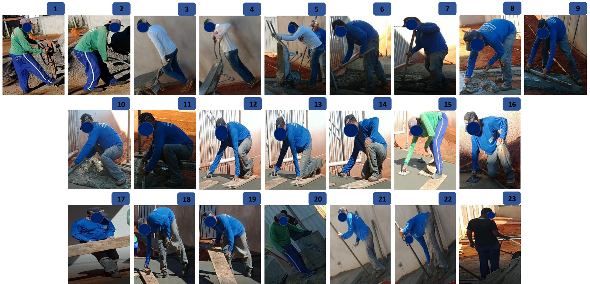
Figura 40: Resultados REBA – execução da camada de contrapiso
