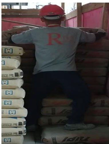
Figura 50: Depósito com espaço muito limitado
