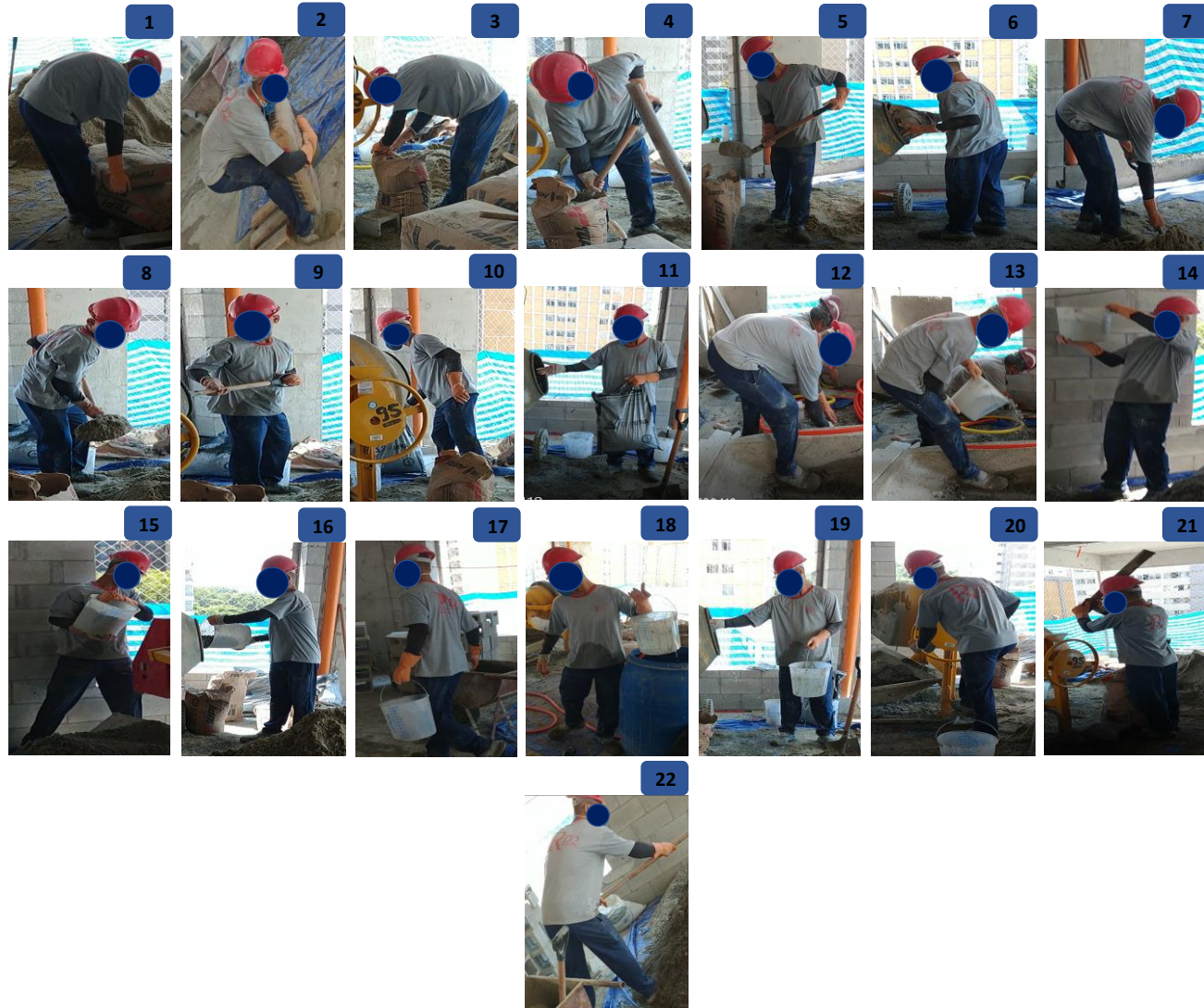
Figura 34: Posturas – preparação da argamassa
