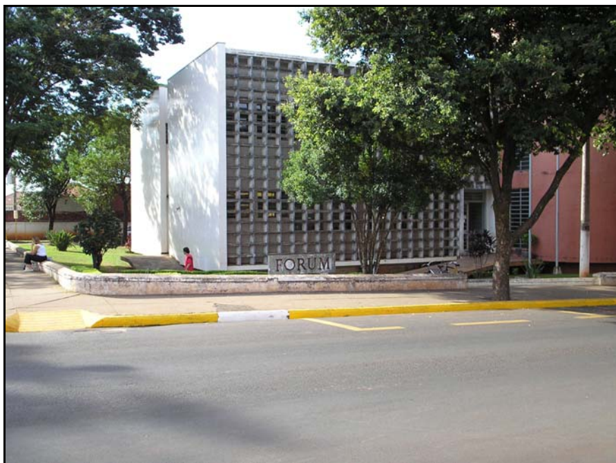
Figura 58 - Fórum da Comarca de Guariba (2005).
