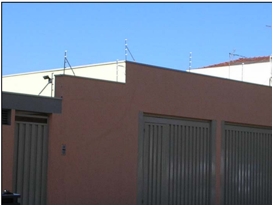
Figura 67 – Cercas elétricas em uma casa no Jd. Boa Vista, bairro nobre da cidade (2005).
