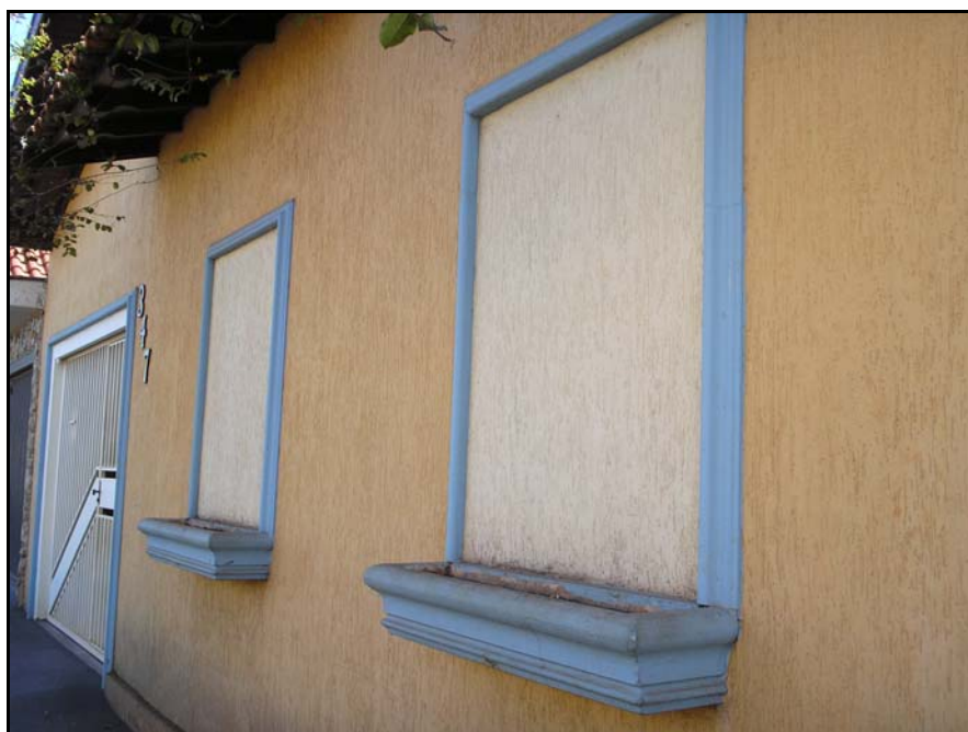
Figura 68 – Janelas que foram fechadas com concreto no centro da cidade.
