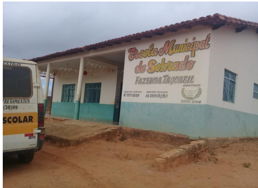
Figura 6- Escola B localizada na comunidade Taquaril área rural de Indaiabira
