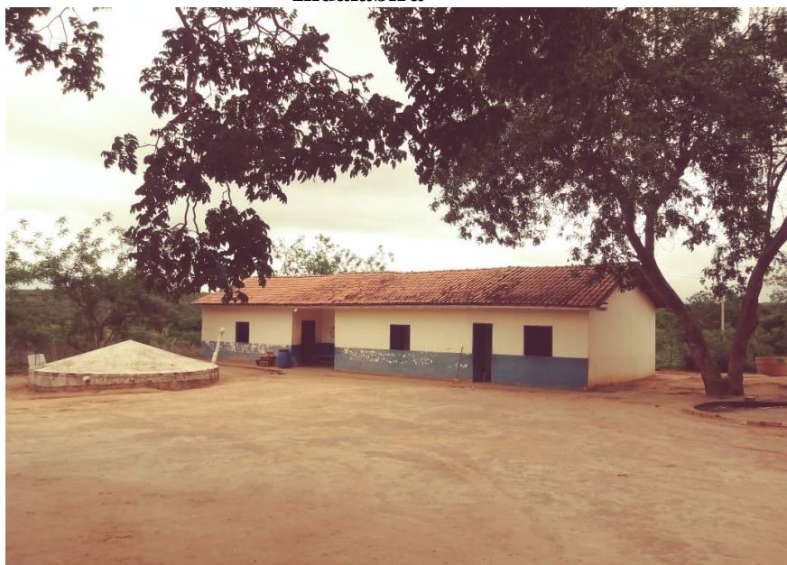
Figura 4- Escola A localizada na comunidade de Muselo na área rural de Indaiabira
