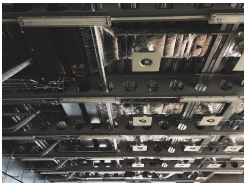
Figura 1.2 – Passagem de tubulações para integração dos serviços
