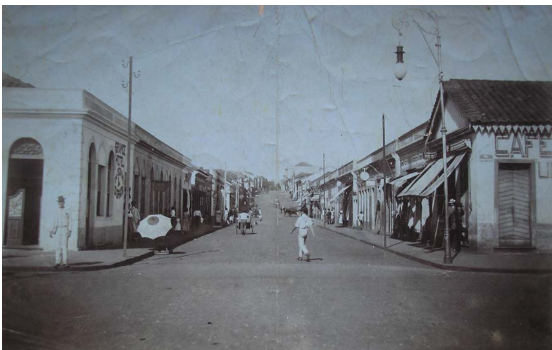
R. General Osório – fim da década de 10 (Foto 115). Autor: Aristides Motta.
