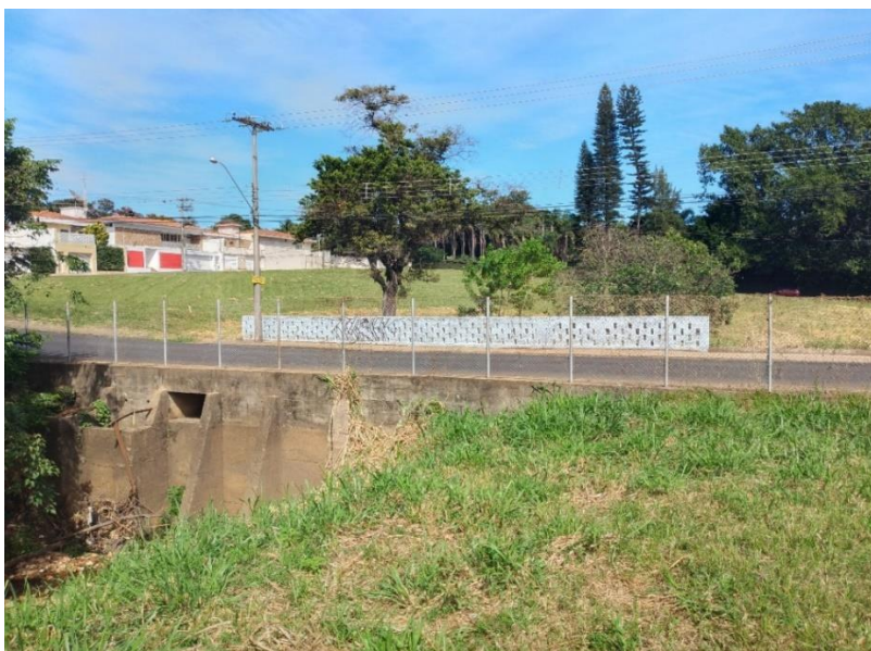
Imagem 05 – Ponte sobre o córrego Tijuco Preto na Rua Miguel Giometti
