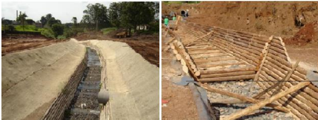
Figura 08 – Renaturalização e destamponamento do Córrego Tijuco Preto.
