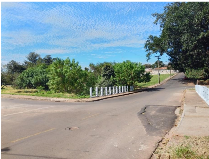
Imagem 04 – Ponte sobre o córrego Tijuco Preto na Rua Marcolino Lopes Barreto esquina com a Rua Maria Tavares Leandro
