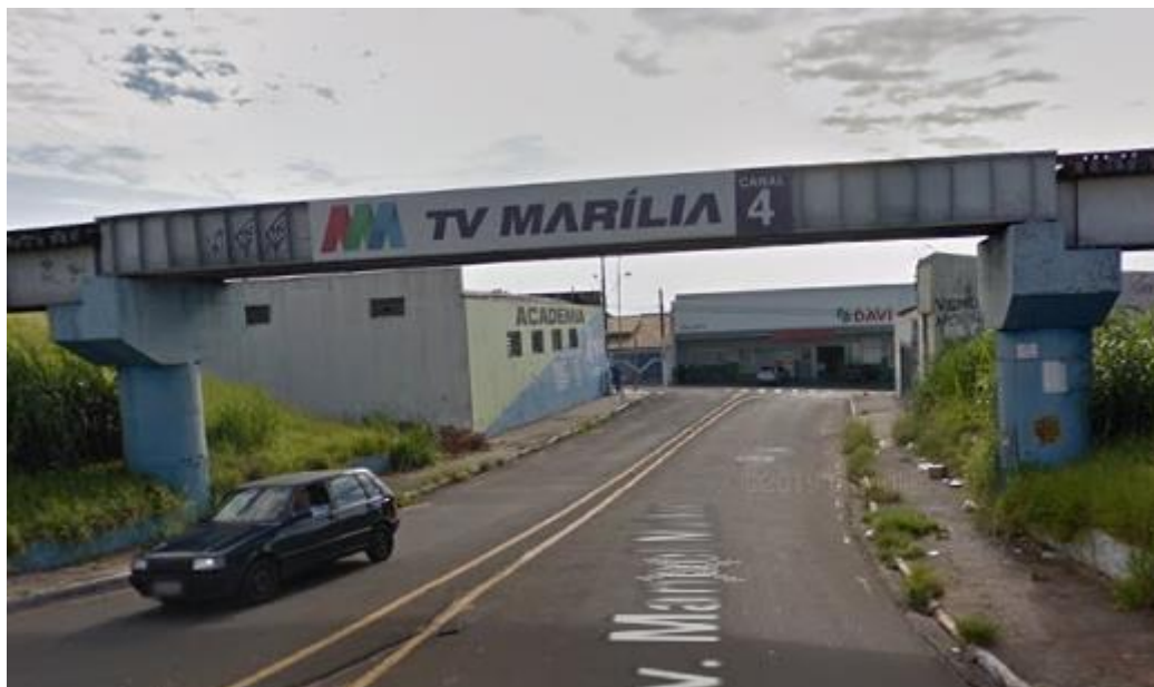
Figura 59: Viaduto ferroviário sobre a Av. Manoel Muller
