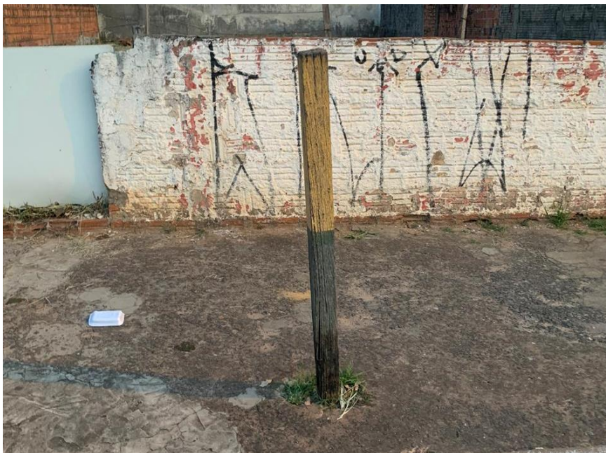
Figura 46: Parada de ônibus com poste de sinalização não padronizado
