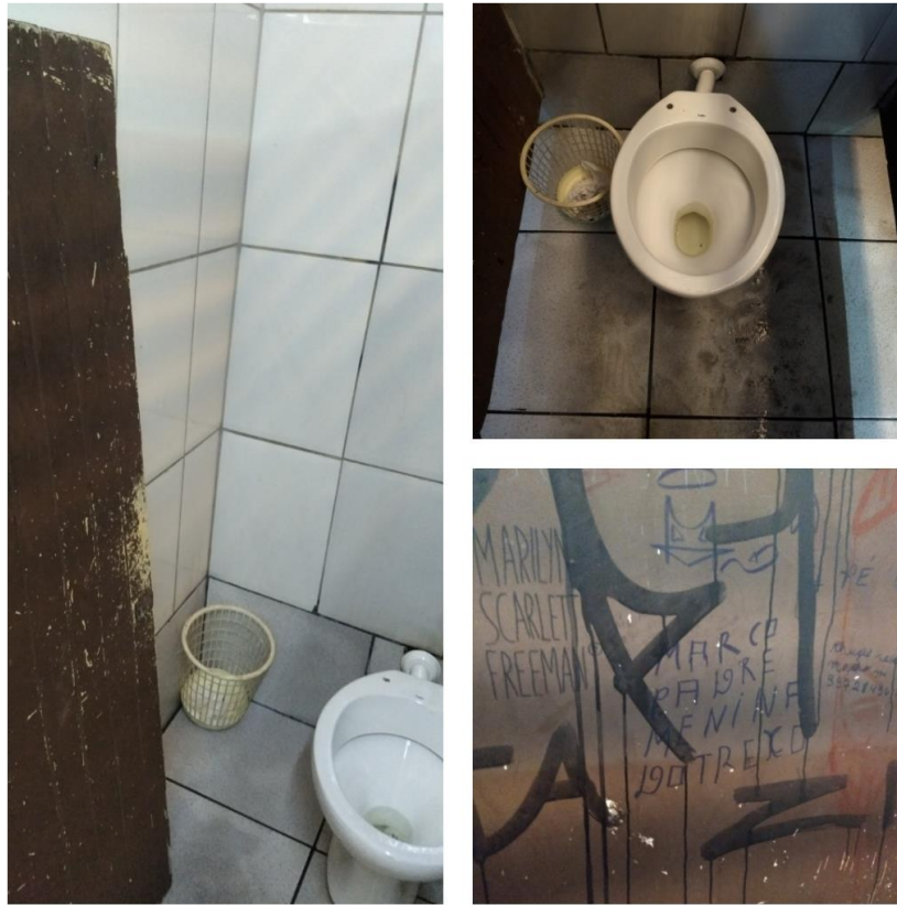
Figura 15: Banheiro Masculino do Terminal
