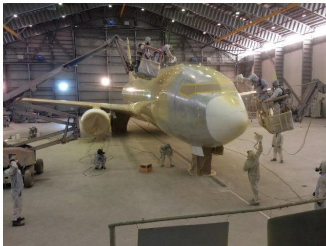
Figura 17: Pintura em regiões de difícil acesso e alturas elevadas.
