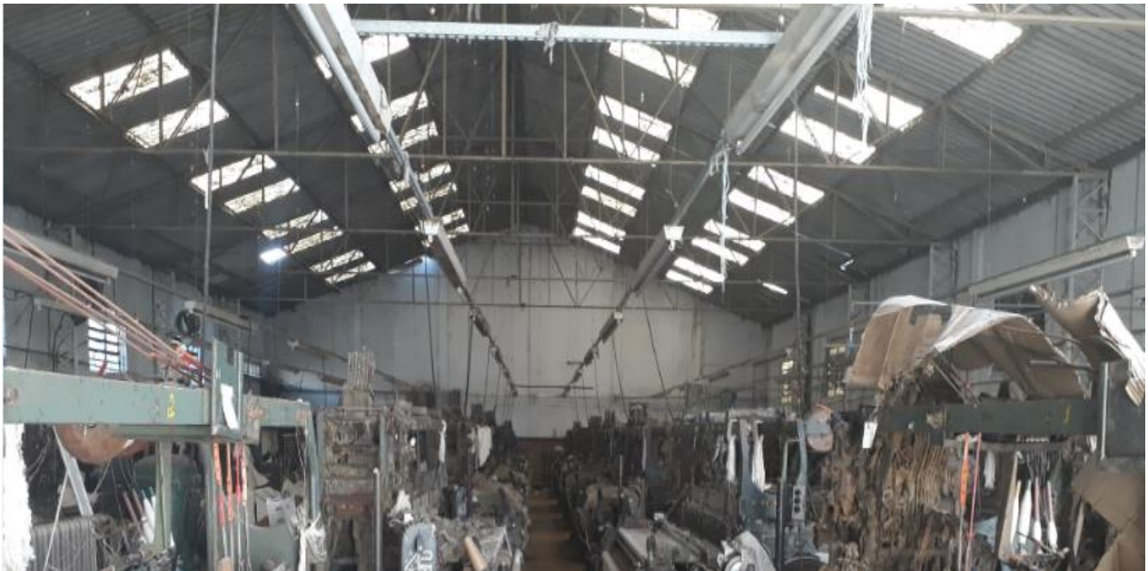
Figura 55 - Vista do telhado da tecelagem com telhas translúcidas
