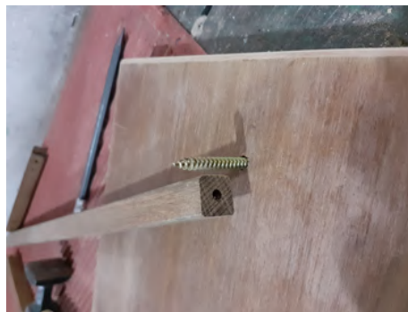
Coluna com furo para o parafuso da base.
