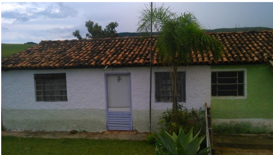
FOTO 6. Casas de trabalhadores da Colônia
