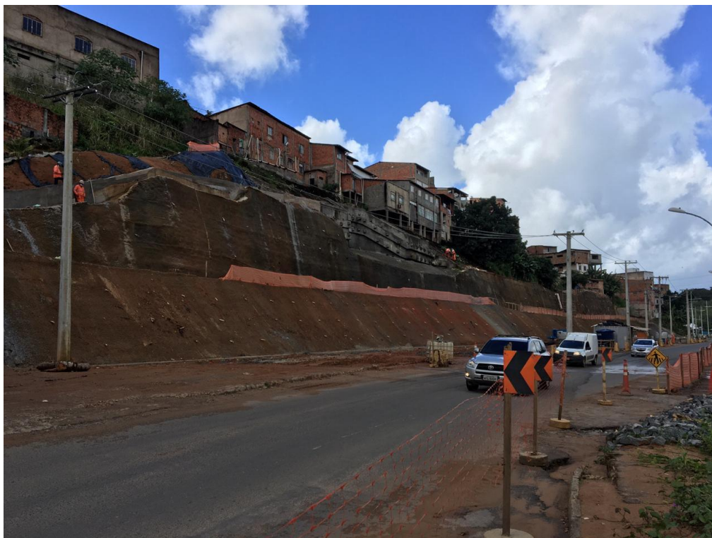
Figura 27 - Vista do “Corte 8”
