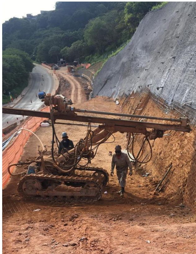
Figura 5 - Perfuratriz utilizada na execução de furos no maciço
