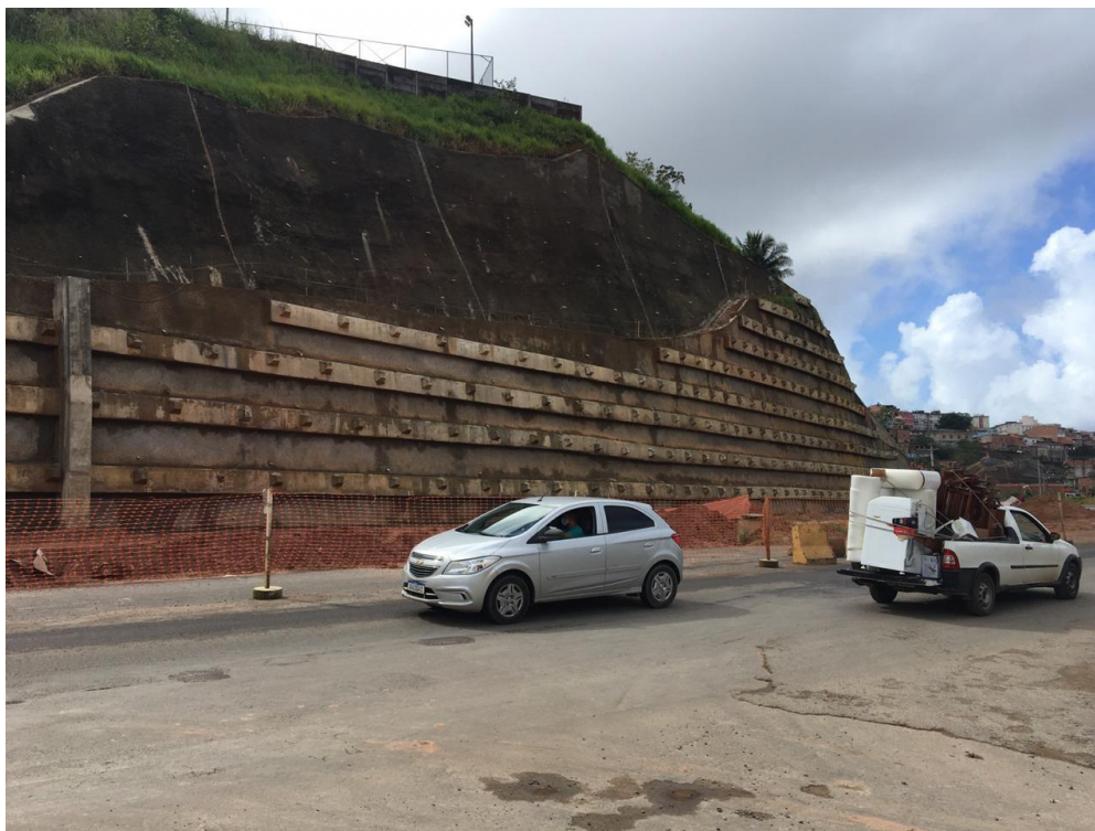
Figura 26 - Vista do “Corte 7”
