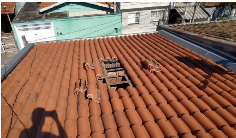
Figura 12 - Local de instalação dos painéis fotovoltaicos
