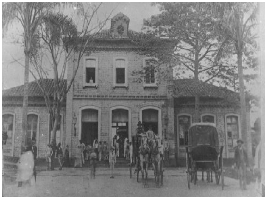
Primeira Estação da Cia. Paulista de Estradas de Ferro em Rio Claro, inaugurada em 11 de agosto de 1876, e demolida em 1910. Fonte: Arquivo Público e Histórico de Rio Claro "Oscar de Arruda Penteadó" (sem data).
