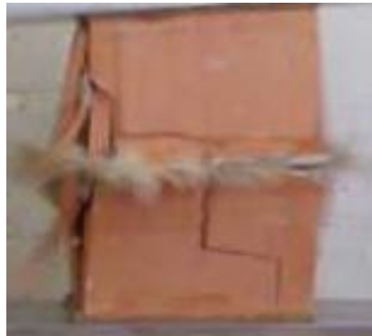
(a) Argamassa mais fraca que o bloco.
