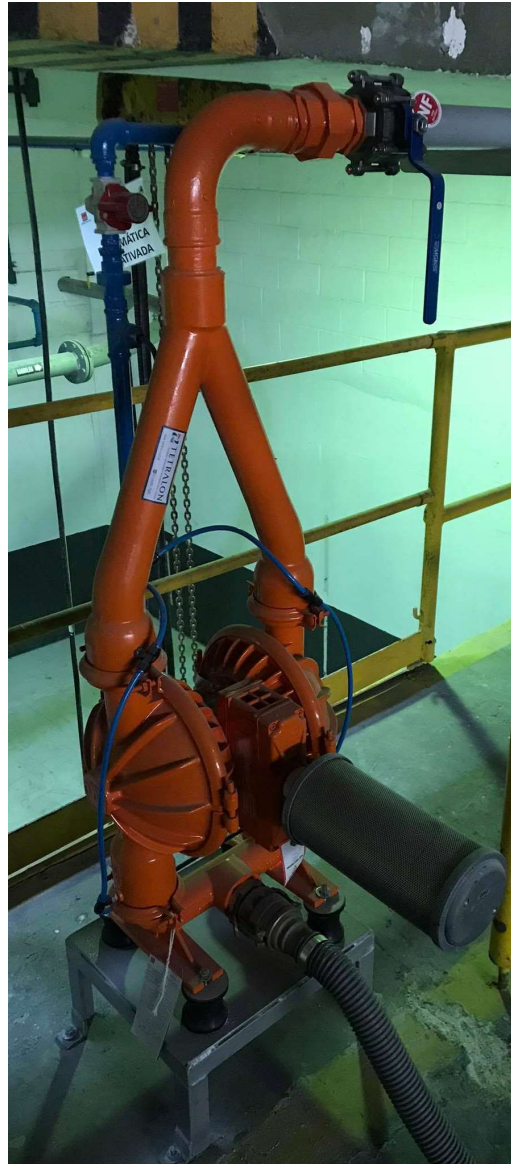
Figura 10 – Bomba AODD proposta para instalação no local
