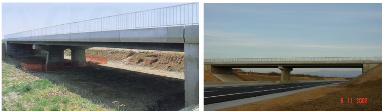
Figura 2.9 – Pontes OA4 e OA6 em conclusão em Bourg-lès-Valence, França
