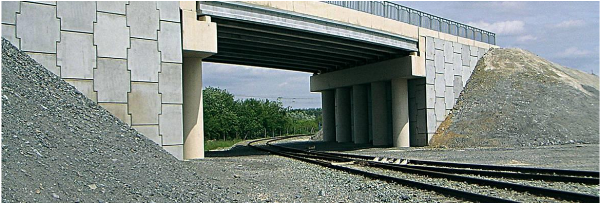
Figura 2.14 – Ponte de Saint-Pierre-la-Cour, França
