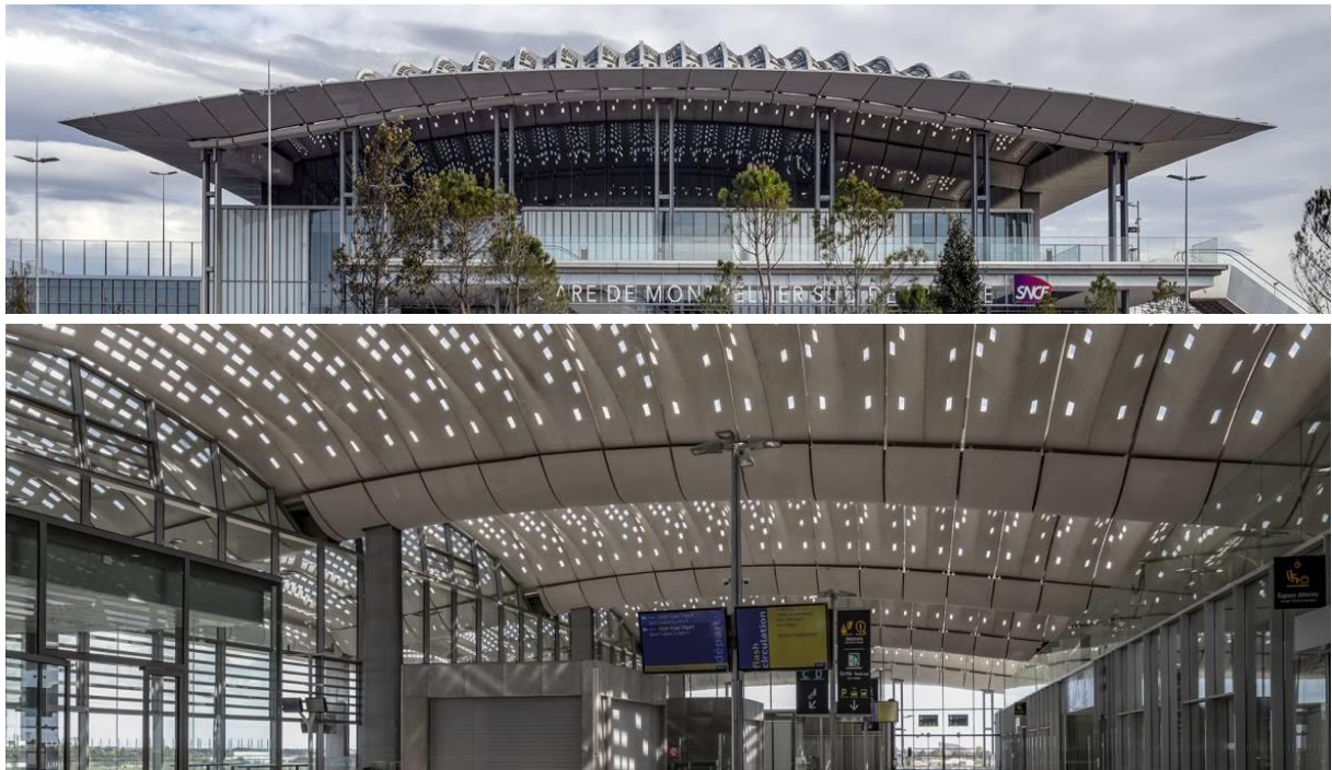
Figura 2.5 – A cobertura da Estação de TGV Montpellier no Sul da França
