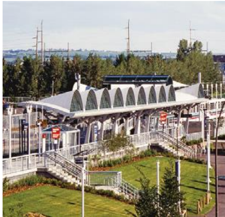
Figura 2.6 – Cobertura da estação de trem após conclusão
