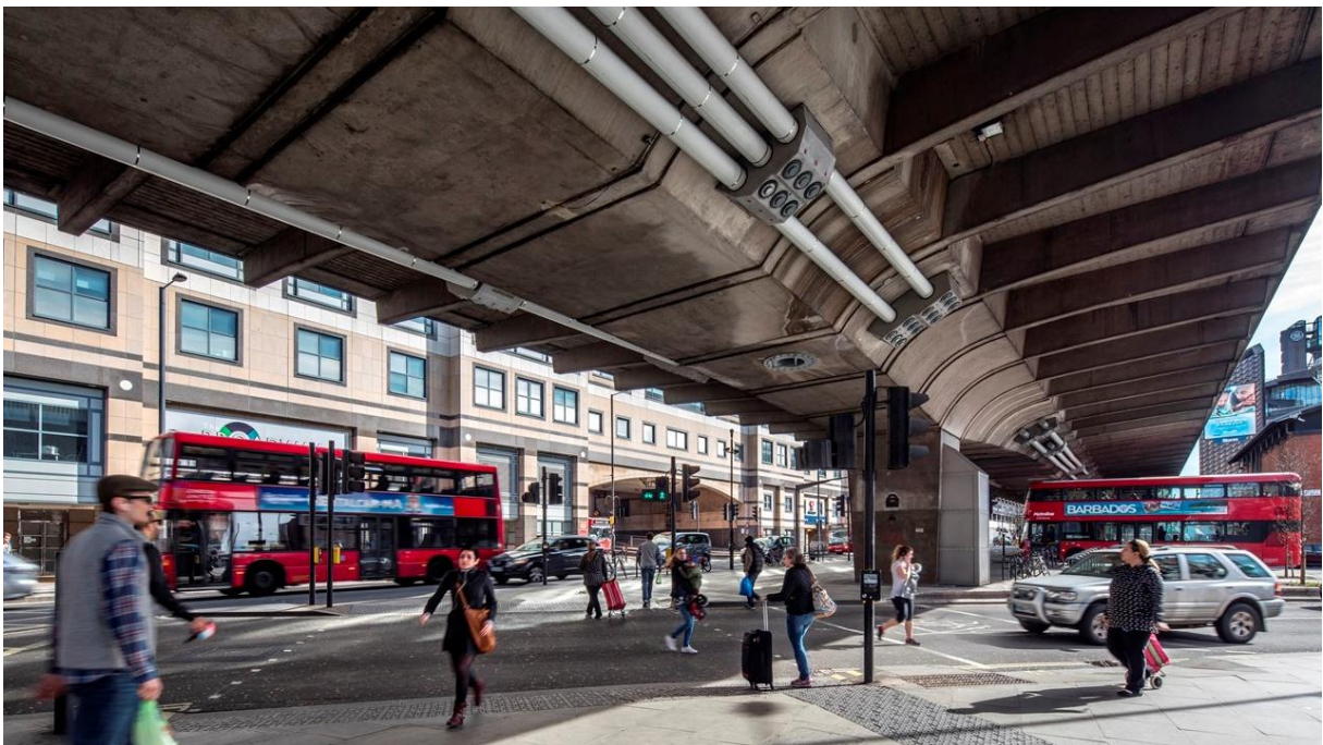
Figura 2.11 – Reforço externo no Viaduto de Hammersmith, Londres, Reino Unido
