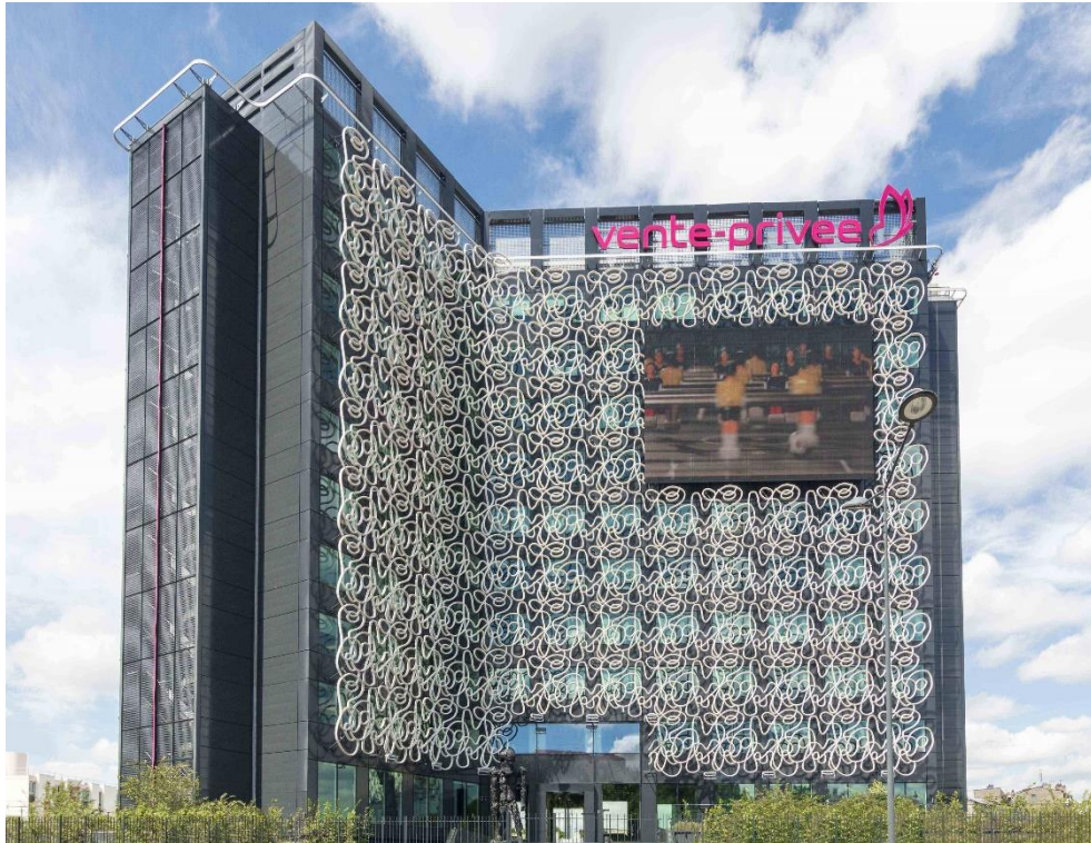
Figura 2.7 – Fachada do Edifício Le Verone em Saint-Denis, França
