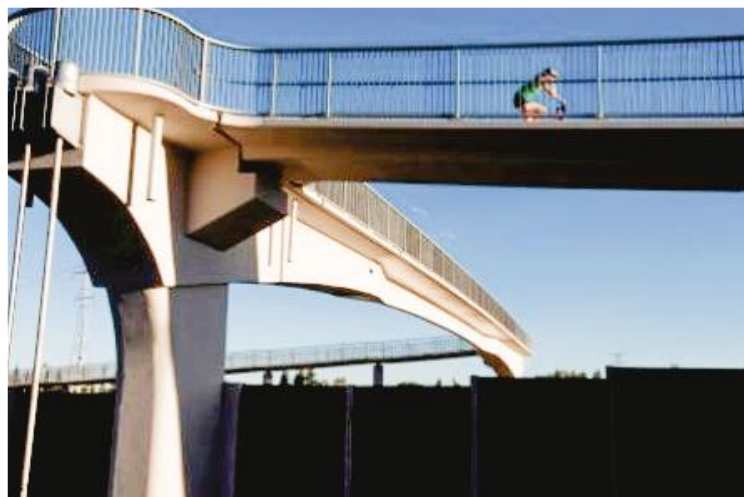
Figura 2.15 – Ponte para pedestre construída em Calgary
