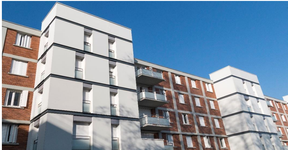
Figura 2.2 – Painéis de revestimento em CUAD em edifício habitacional em Gentilly na França
